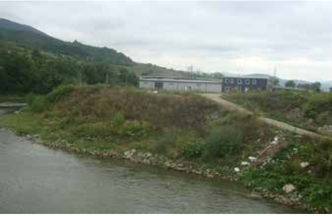
Desna obala Bosne u Zenici prije izvođenja radova
