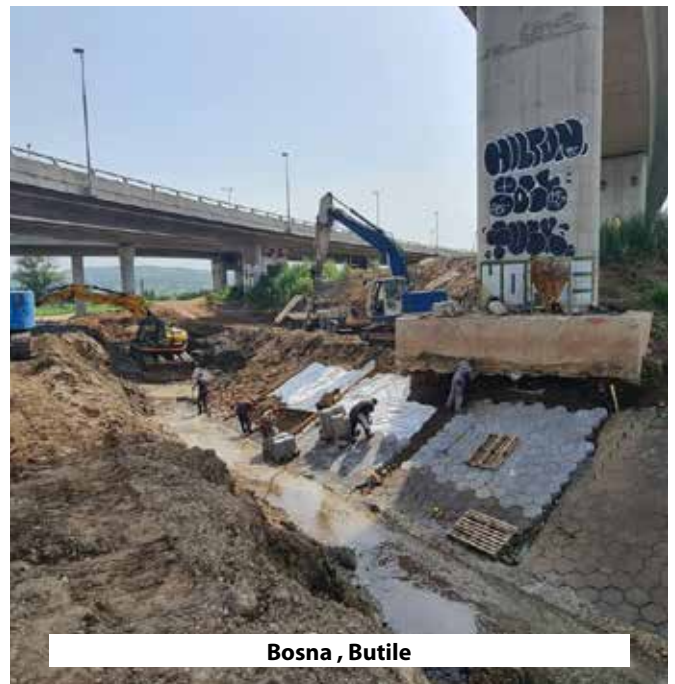
Rekonstrukcija dionice savskog odbrambenog nasipa
