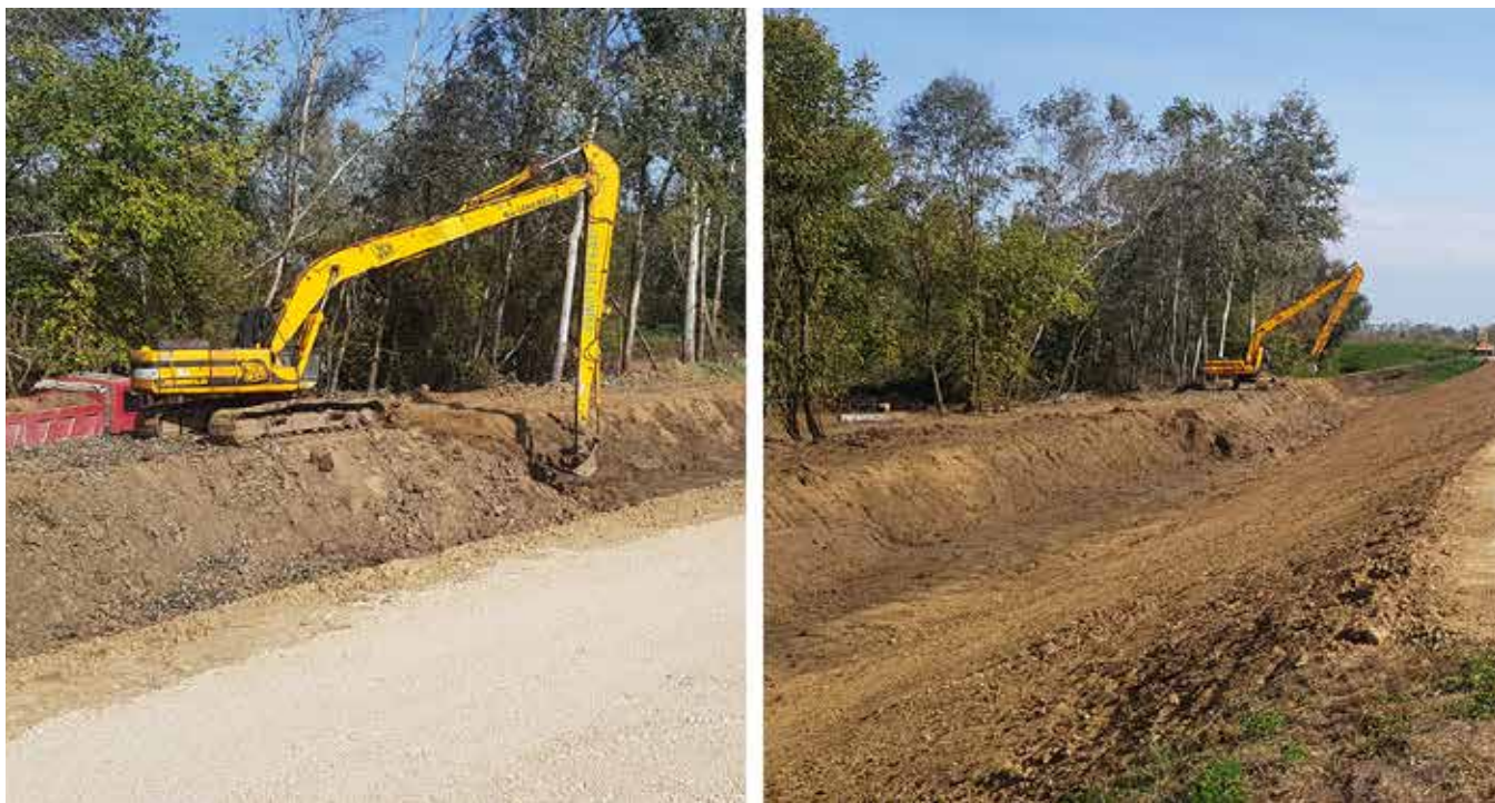
Radovi na sanaciji klizišta i izradi prednasipa
