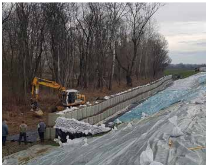
Privremena mjera zaštite klizišta (prekrivanje nasipa i postavljanje box barijera)
