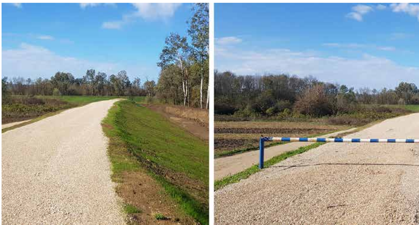
Uspješno realizirana sanacija klizišta
