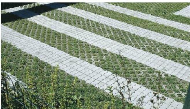
Slika 5. Prikaz betonske travnate rešetke [10]
