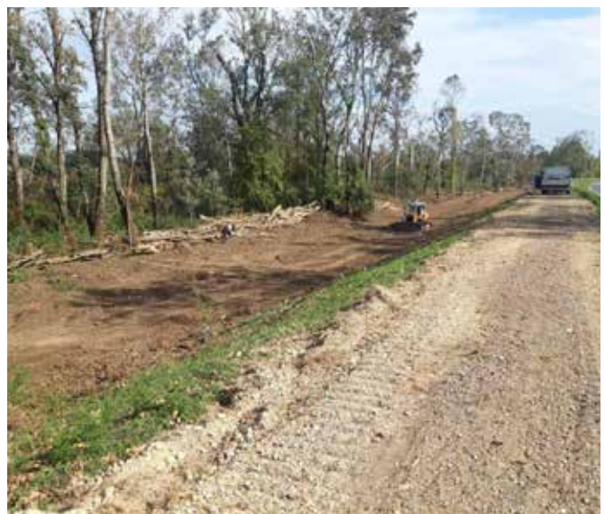
Krajnji cilj: Nadvišenje krune nasipa od 0,20 m do 0,90 m
