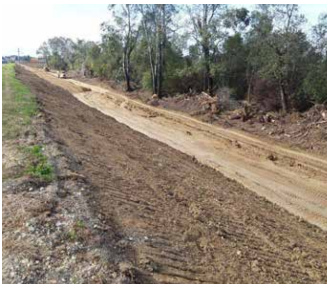
Krajnji cilj: Nadvišenje krune nasipa od 0,20 m do 0,90 m
