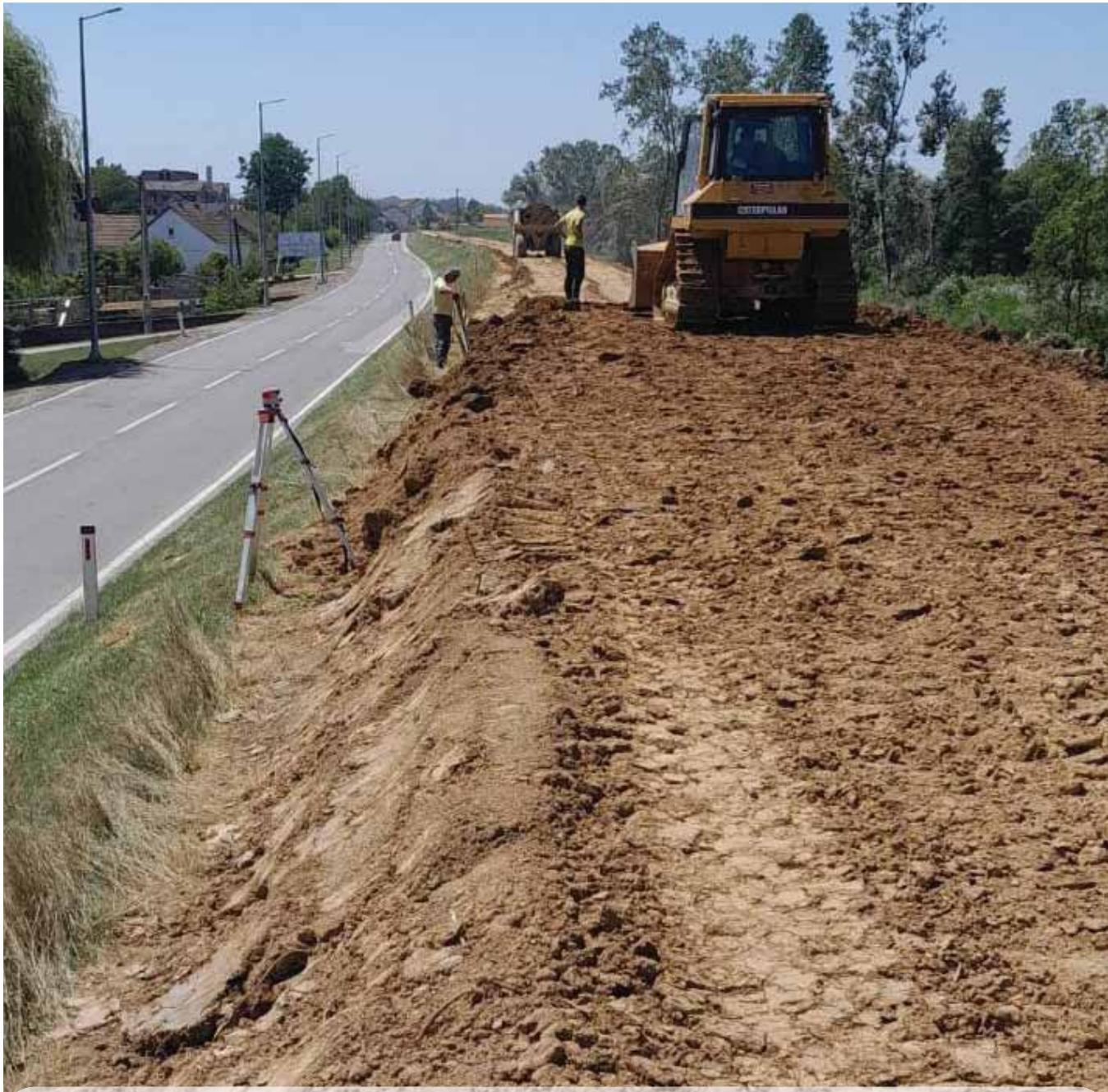
U toku su radovi na rekonstrukciji savskog odbrambenog nasipa na području Srednje Posavine. Riječ je o dionici od km 31+315 do km 32+950. Okončanjem navedenih radova, kompletan savski odbrambeni nasip na području Federacije BiH imat će potrebno zaštitno nadvišenje, odnosno 1,20 m iznad kote velike vode rijeke Save ranga pojave 1/100.
