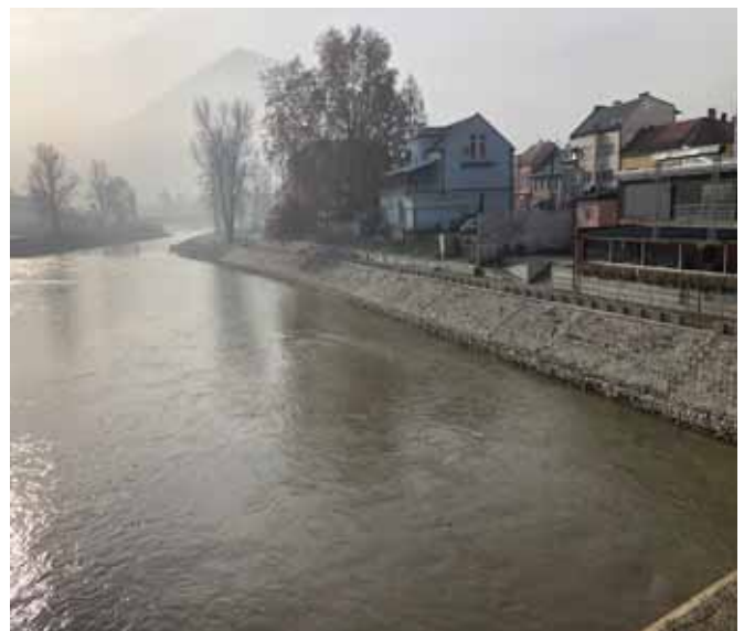
Lijeva obala Bosne u Visokom uzvodno od mosta
