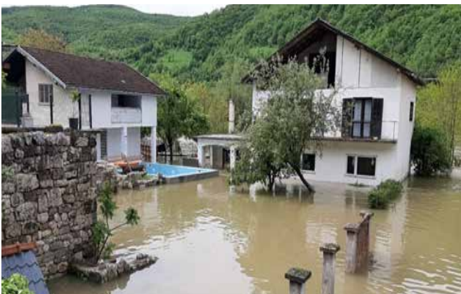
Objekti u Kulen-Vakufu nisu izdignuti iznad linije stogodišnjih voda
