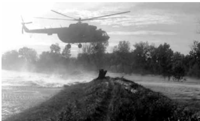
Hitna sanacija puknuća nasipa u Kopanicama na rijeci Savi, Maj 2014.
