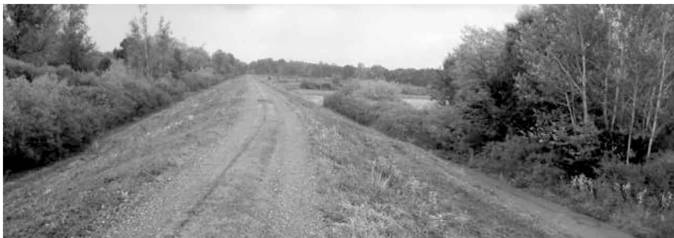
Odbrambeni nasip uz rijeku Savu u Odžačkoj Posavini
