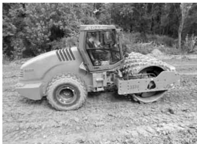
Sl. 3. i 4. Proces zbijanja (ugradnje) glinovitog materijala u trup nasipa, Lokalitet Prud, Odžak.
