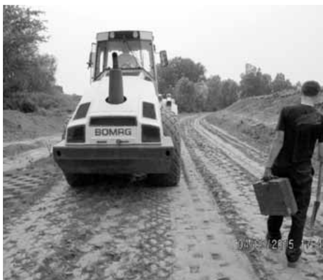
Sl. 5. i 6. Proces zbijanja (ugradnje) glinovitog materijala u trup nasipa, Lokalitet Tursinovac, Domaljeva-Šamac.
