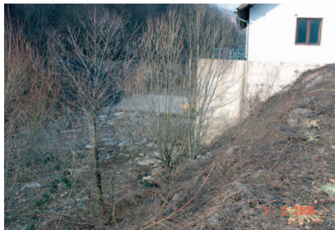
Slika br. 4. Mala hidroelektrana na rijeci Osanici (pritoka r. Drine), snimio Sanjin Uković
