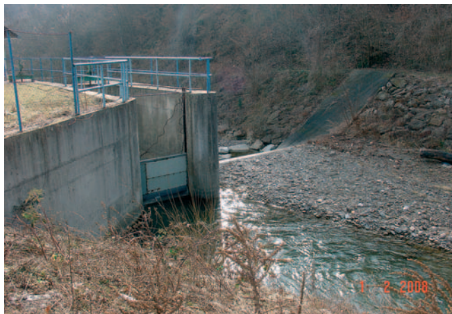
Slika br. 3. Mala hidroelektrana na rijeci Osanici (pritoka r.Drine), snimio Sanjin Uković
