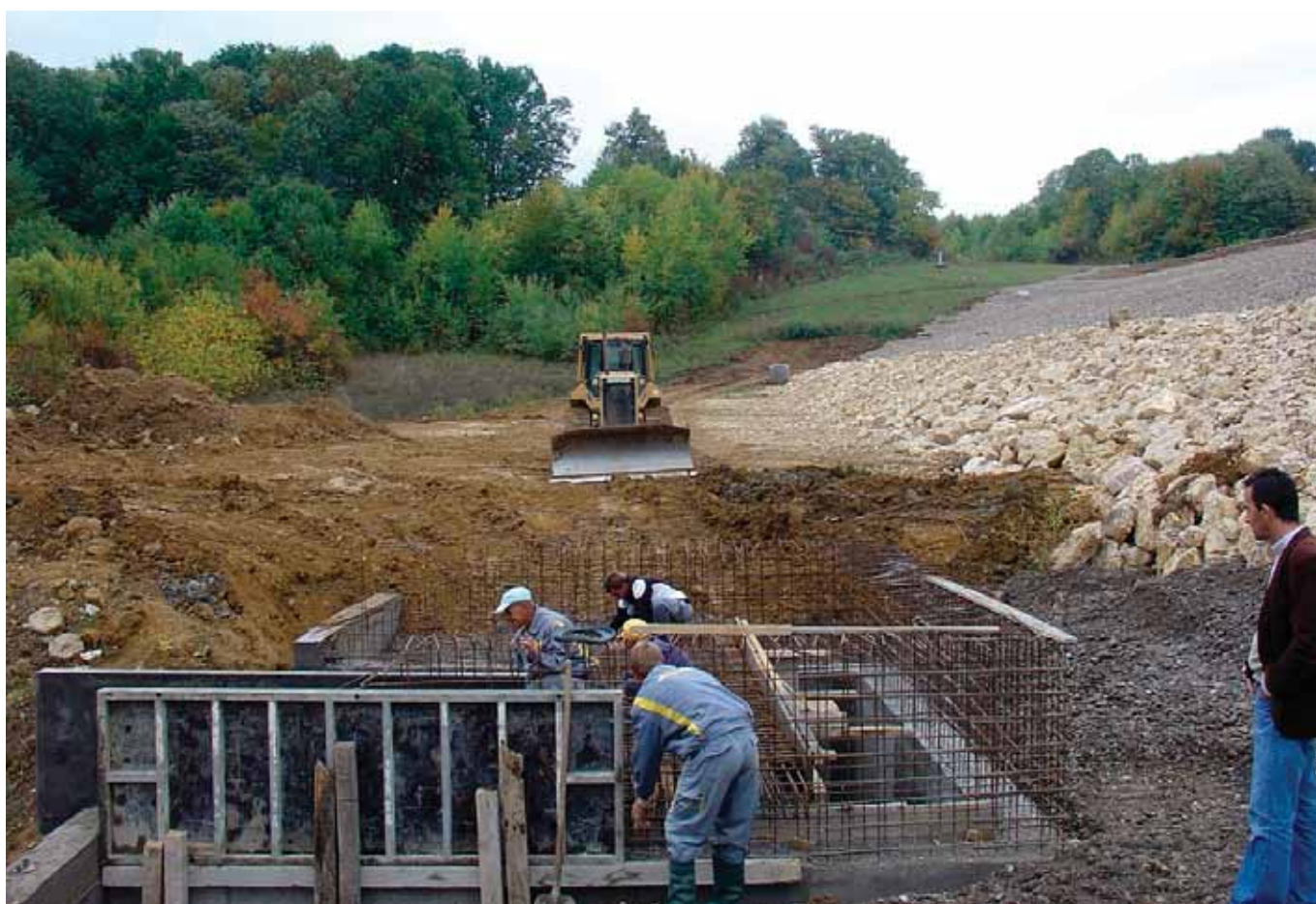
Disipacioni objekat u izgradnji
