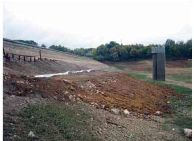
Interventni radovi na uzvodnoj kosini
