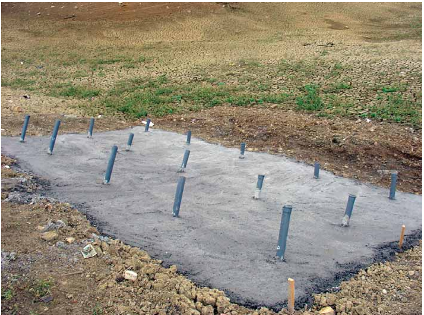
Sanacija infiltracione zone
