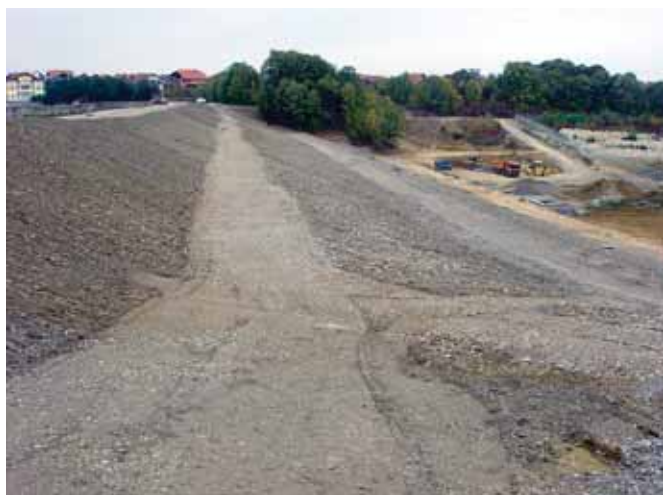
Radovi na nizvodnoj kosini brane
