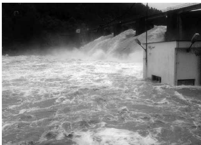
Slika 6. Rad prelivnih organa brane Modrac 16. 05. 2014. za vrijeme maksimalnog nivoa na profilu Brane Modrac (203,42 m.n.m)
