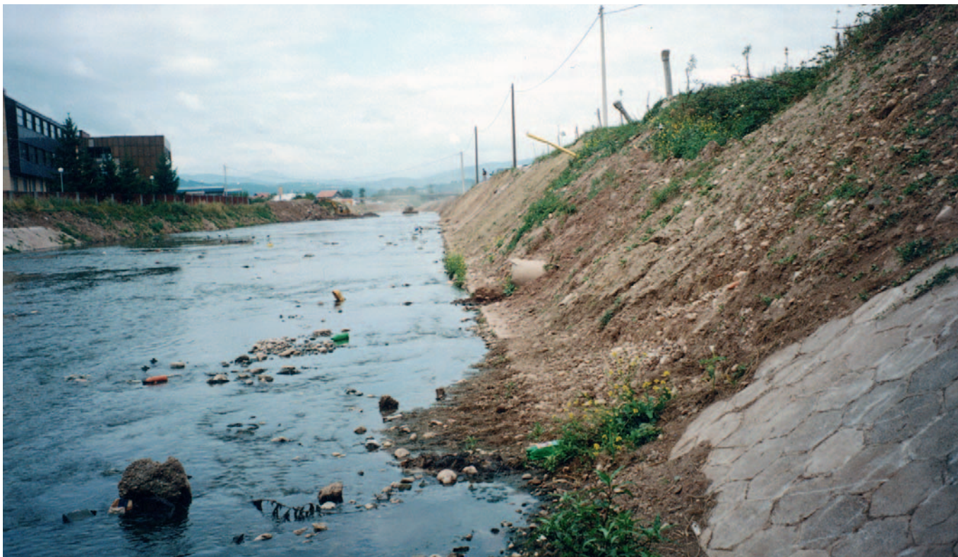
Čišćenje korita rijeke Miljacke nizvodno od Sarajeva
