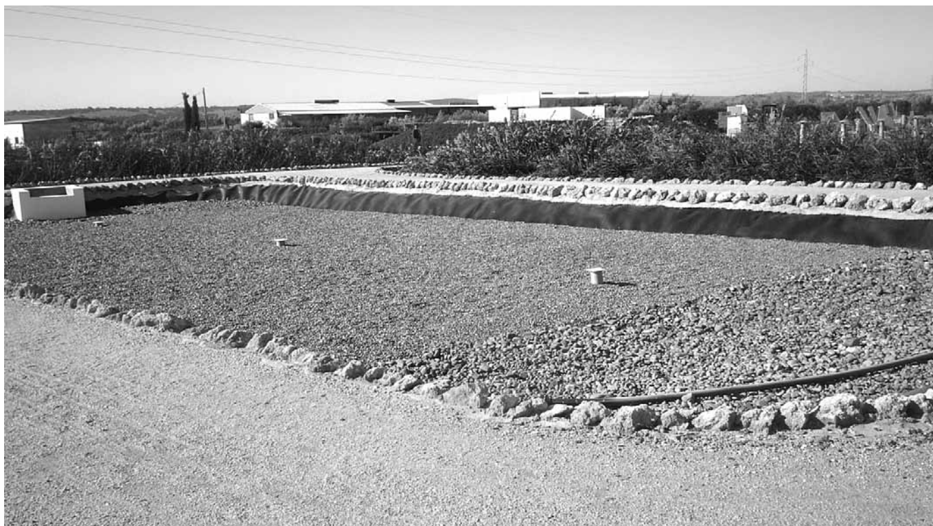
Eksperimentalno postrojenje. Priprema podloge za formiranje vještačke močvare
