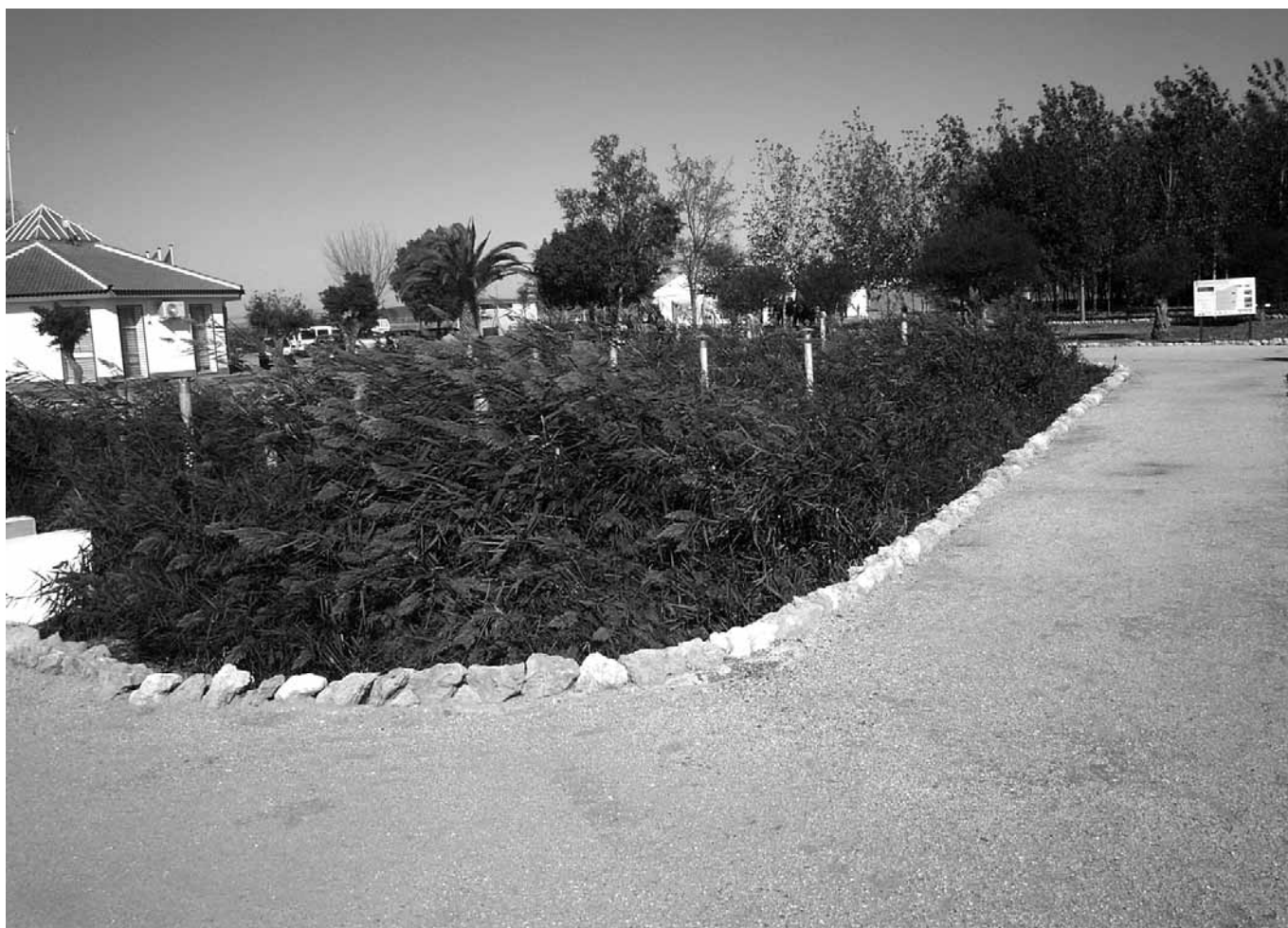
Eksperimentalno postrojenje. Formirano polje vještačke močvare sa aeracionim cijevima
