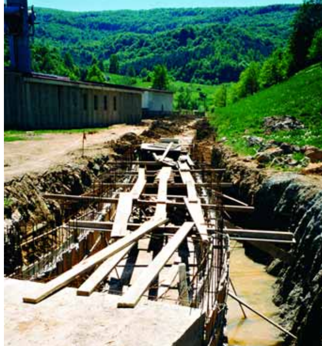
Faza izgradnje regulacije u Ključu
