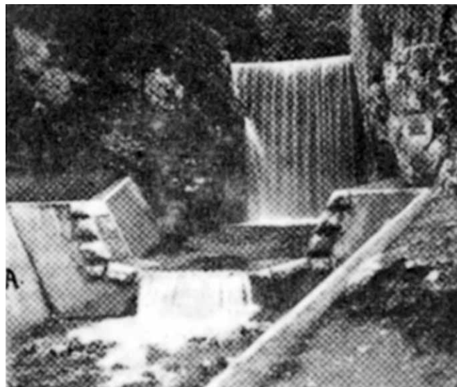
Sl. 1. - Pregrada za zaustavljanje nanosa u jednom bujičnom toku u Austriji
