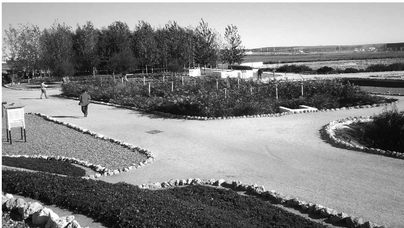
Ekperimentalno postrojenje. Kultivisana područja vještačkih močvara na pilot postrojenju
