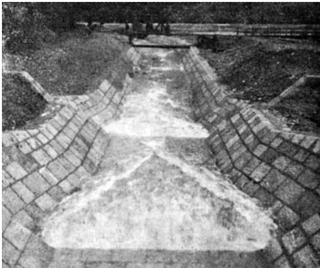
Sl. 3. - Dio kinete u bujičnom toku "Dobrinja" u krugu hidroelektrane Jablanica
