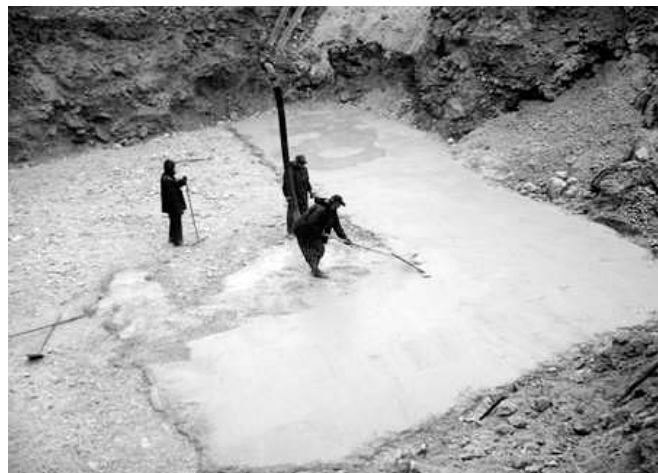
Podložni beton za temeljnu ploču praga broj 4
