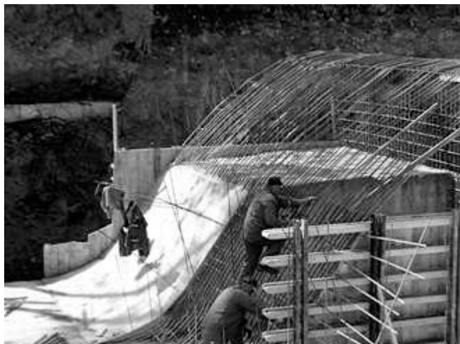
Armiranje i betoniranje praga broj 4
