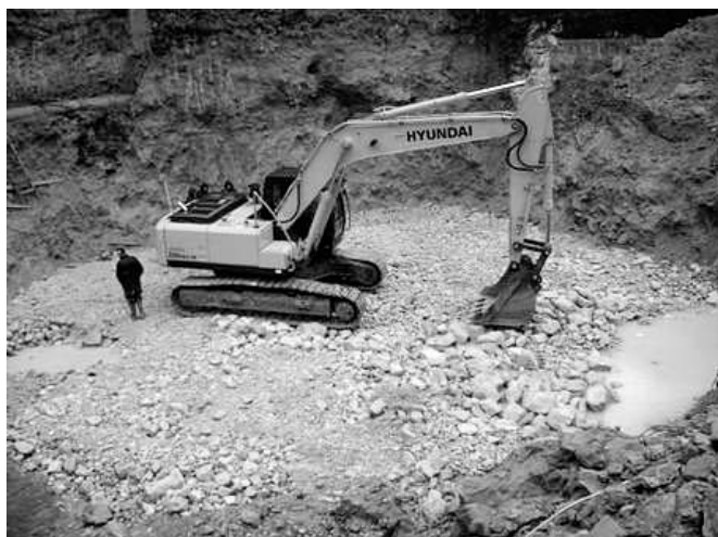
Zamjena podtla ispod temeljne ploče praga broj 4
