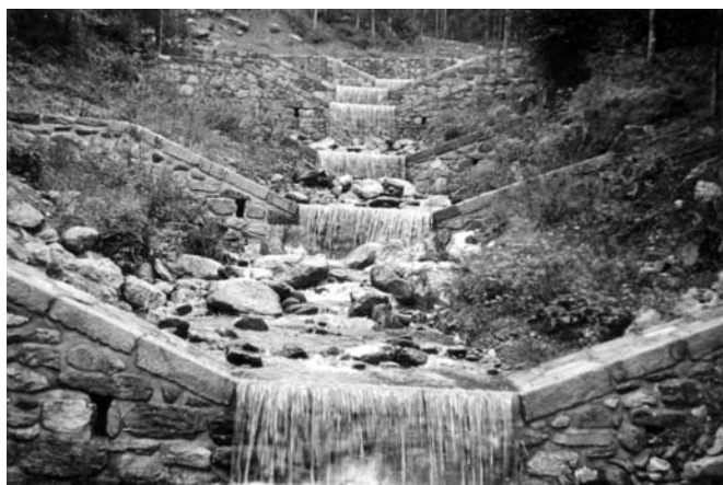
Sl. 7. Uređene bujice sistemom pragova od kamena u cementnom malteru
