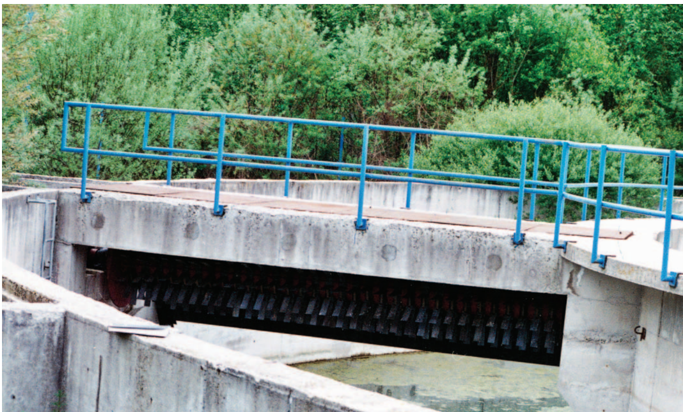
Dio devastiranog postrojenja za tretman otpadnih voda Trnova - mamut rotor
