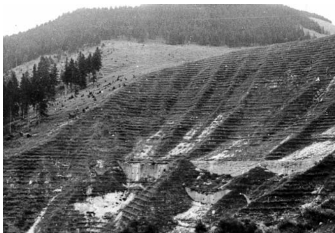
Sl. 4. Eroziono područje poslije tretmana antierozionim radovima
