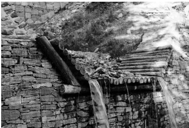
Sl. 6. Pregrada od gabiona s aprelivom obloženim drvenim oblicima
