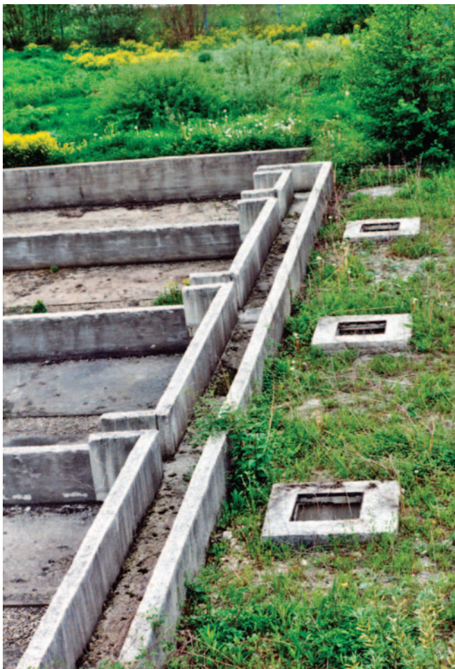
Još jednom devastirani uređaj u Trnovu: polja za sušenje mulja
