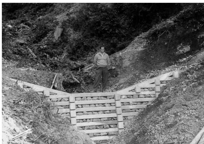
Sl. 5. Prag u bujičnom toku od armirano betonskih elemenata
