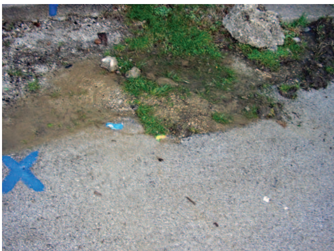
Slika 2.1. Izgled i način obilježavanja kvara u slučaju oštećenja i gubitka vode u vodovodnom sistemu
