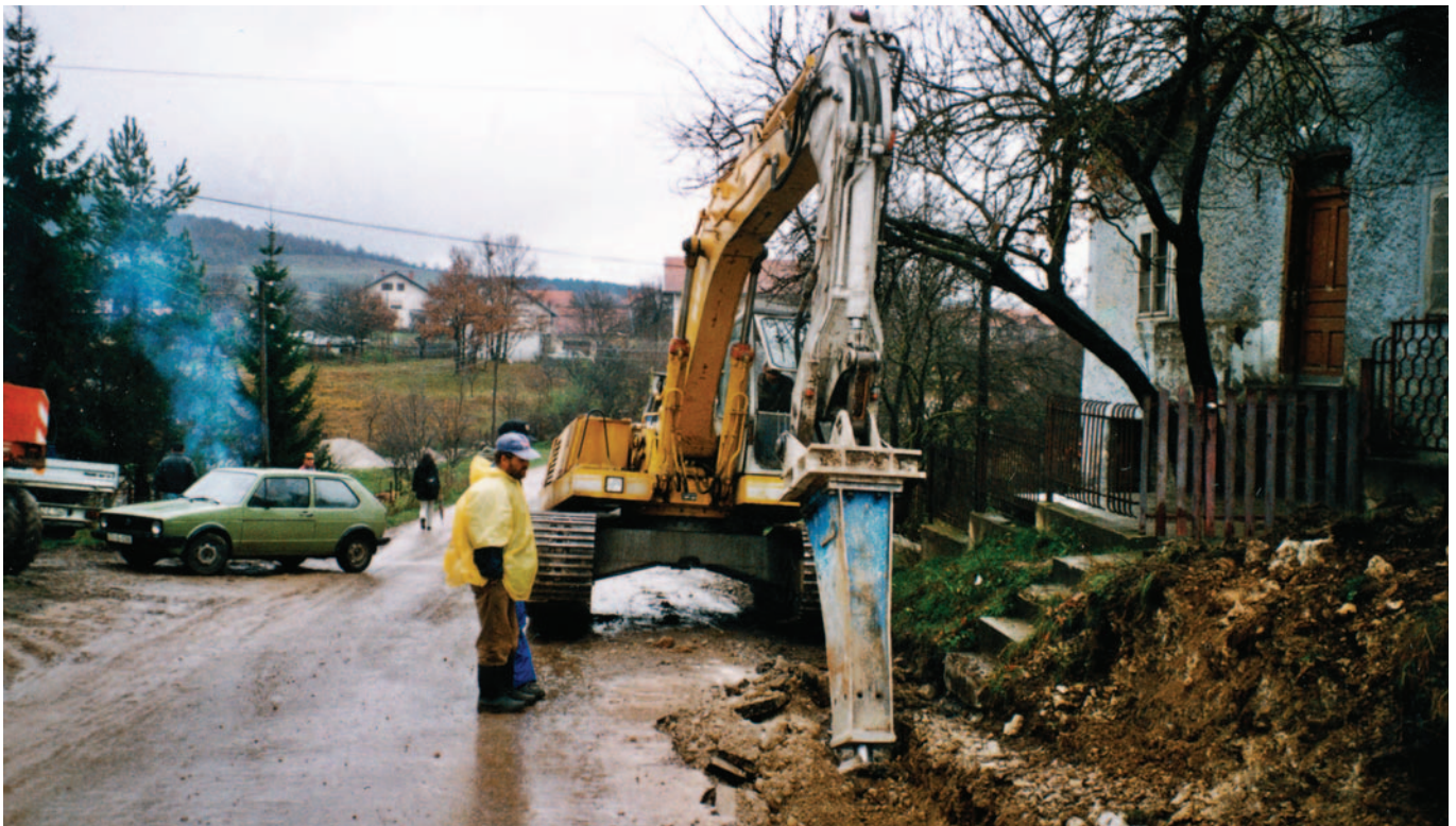
Pripremni radovi za polaganje cijevi
