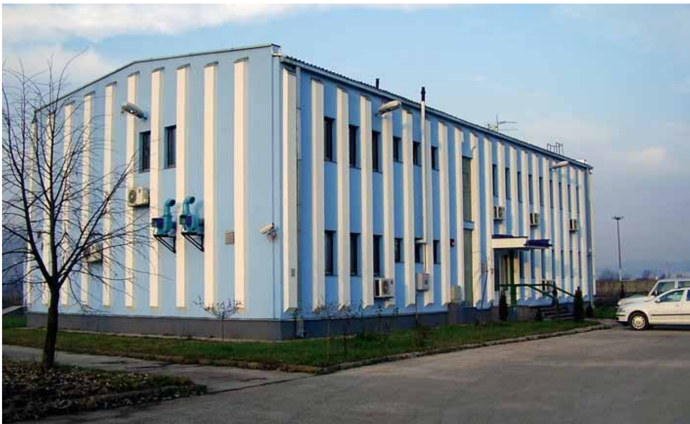
Zgrada vodoprivredne laboratorije AVP Sava u Butilama kod Sarajeva
