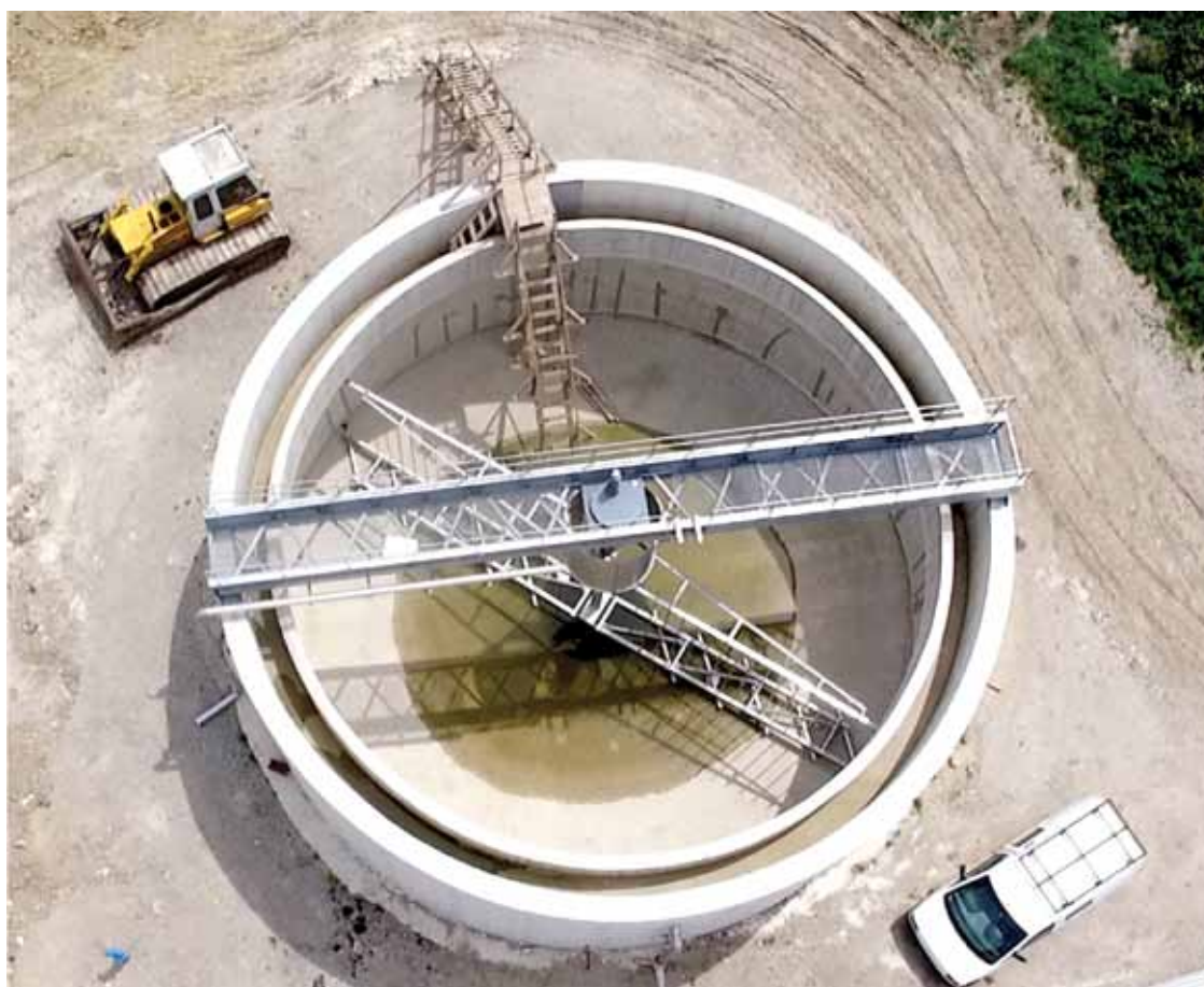
Slika br.6: Gravitacioni ugušivač
