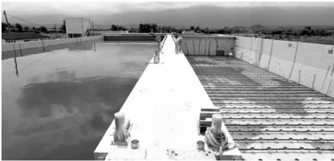
Slika br.11: Bazen sa aktivnim muljem – difuzori za aeraciju
