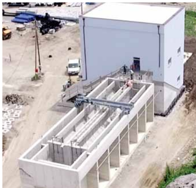
Slika br.3: Zgrada sa finim rešetkama i aerisani pješkolov sa mastolovom
