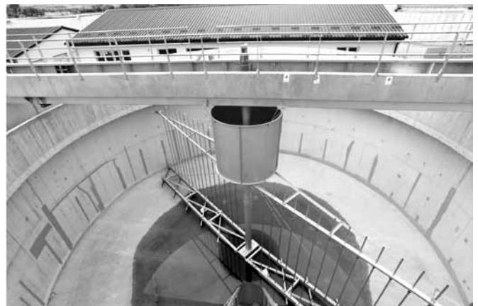
Slika br.13: Gravitacioni ugušćivač mulja – mostni zgrtač
