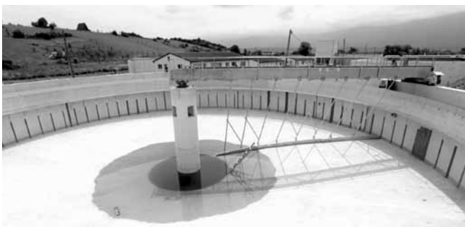
Slika br.12: Finalni taložnik – mostni zgrtač
