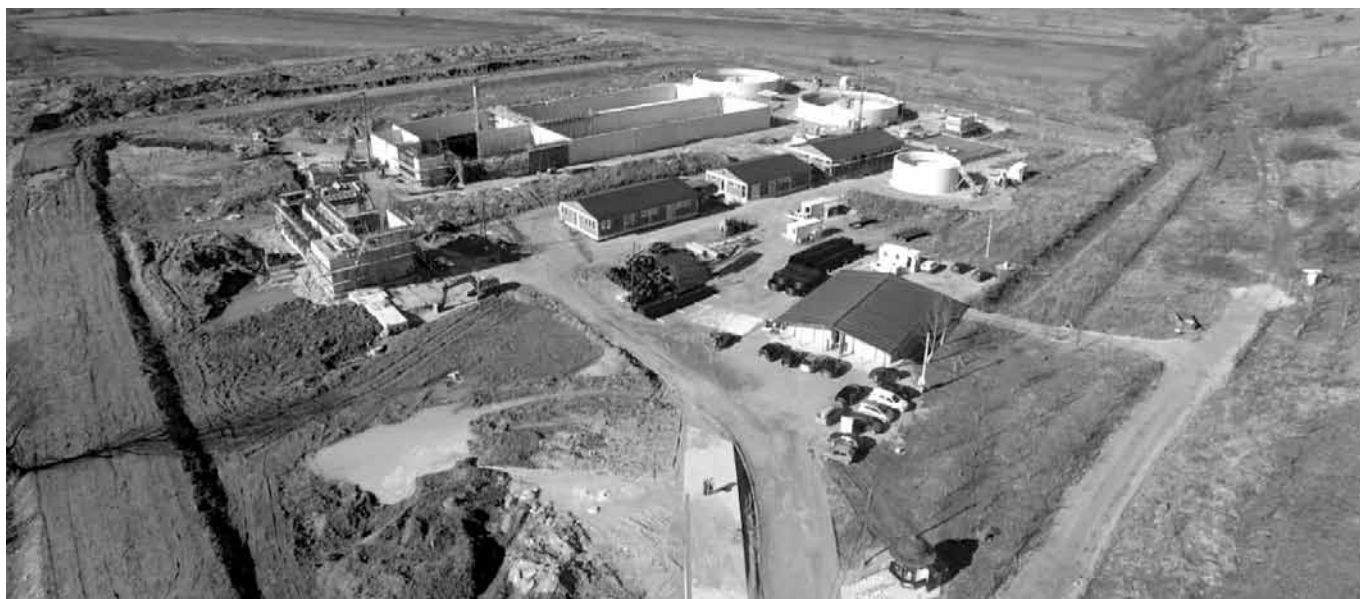
Slika br.8: PPOV Bihac – odbrambeni nasip(brana) oko objekata u fazi izgradnje-mart 2016. Godine
