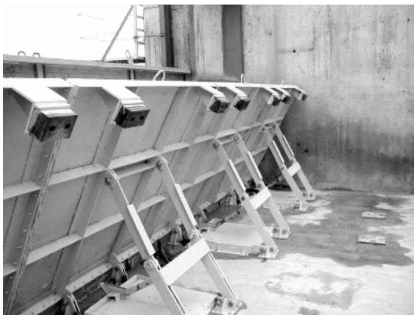
Slika 2: Pogled na sklopivu ustavu sa nizvodne strane
