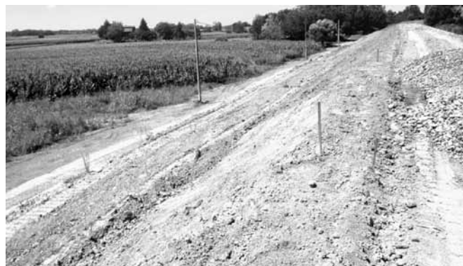
Slika 3. Sanacija i rekonstrukcija kritičnih dionica savskog odbrambenog nasipa u Vučilovcu, Brčko distrikt BiH (stacionaža km 7+328,54 do km 7+879,95), Kredit Svjetske banke – Hitni projekat odbrane od poplava
