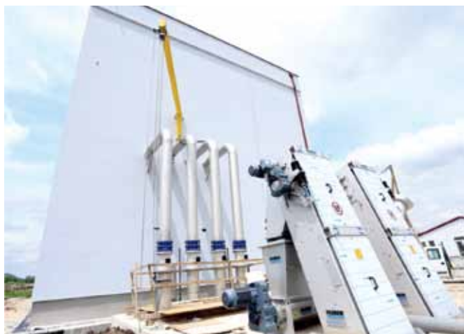
Slika br.4: Ulazna građevina sa grubim rešetkama i zgrada sa finim rešetkama
