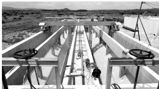
Slika br.10: Taložnik za pijesak i masnoću – ustave, cjevne veze za aeraciju i zgrtač masti i pijeska
