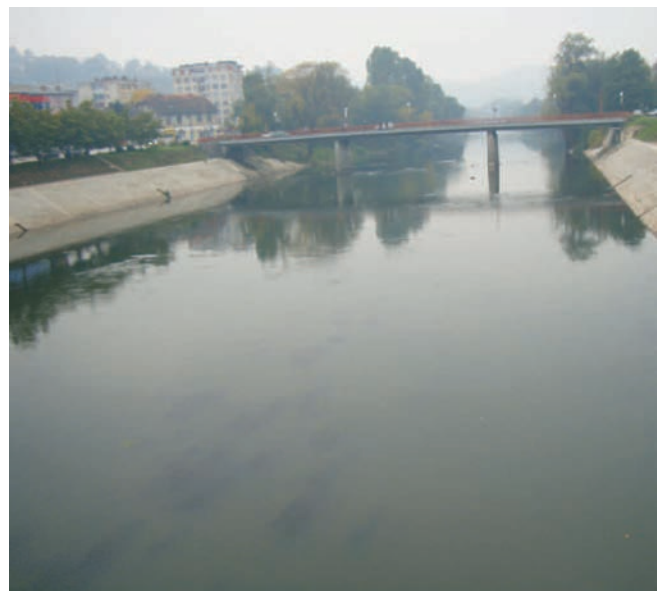
Slika 1– Zavidovići, uređenje obala rijeke Bosne nakon radova
