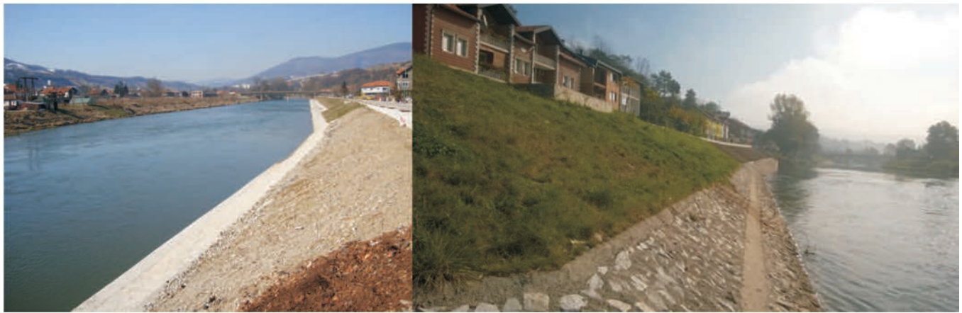
Slika 4 i 5– Kakanj, desna obala rijeke Bosne nakon radova
