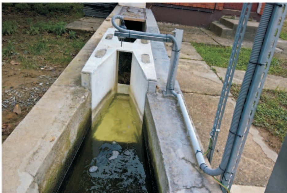
Slika 14. Venturijev mjerac protoka
