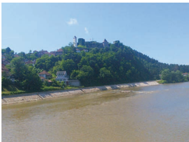
Slika 6– Maglaj, desna obala rijeke Bosne uzvodno od mosta nakon radova
