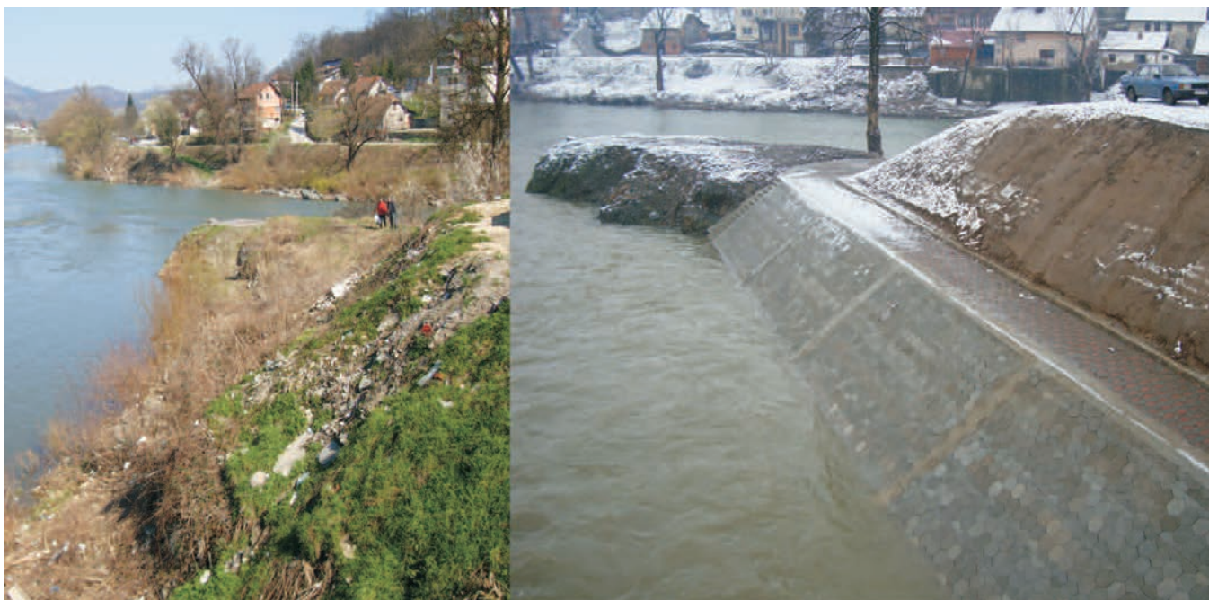
Slika 4 i 5 – Zavidovići, desna obala r. Bosne prije samog ušća Krivaje, prije i nakon radova
