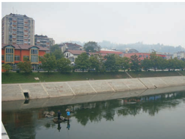
Slika 2– Zavidovići, desna obala rijeke Bosne nakon radova
