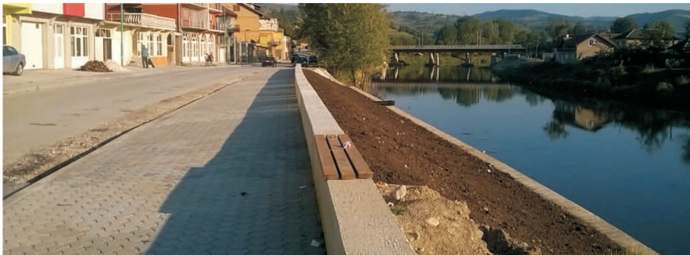
Slika 1,2 i 3– Kakanj, desna obala rijeke Bosne prije, u toku i nakon radova
