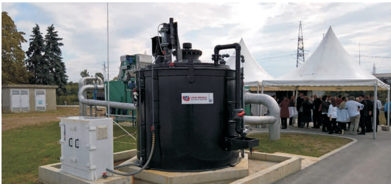
Slika 13. Hemijski tretman uklanjanja fosfora
