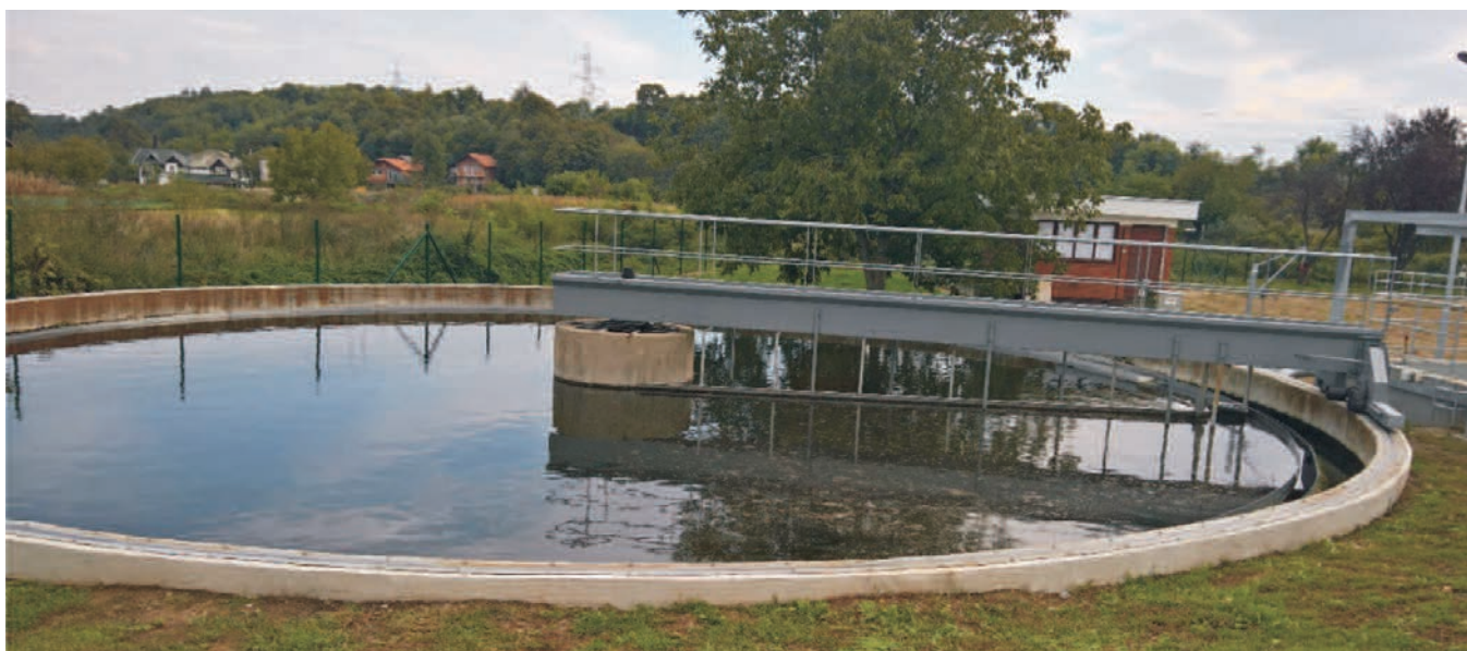
Slika 11. Kružni naknadni taložnik sa zgrtačem
