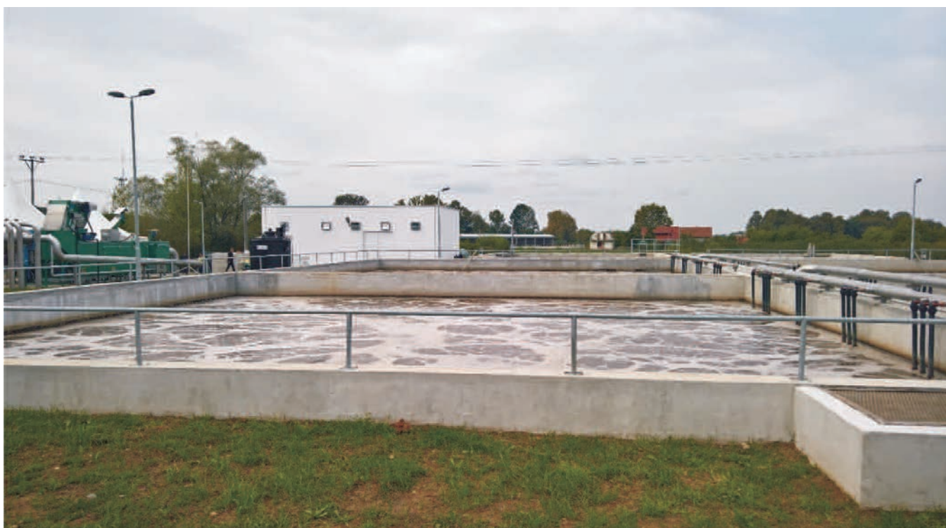
Slika 8. Biološki tretman sa aeracijom – denitrifikacija , nitrifikacija
