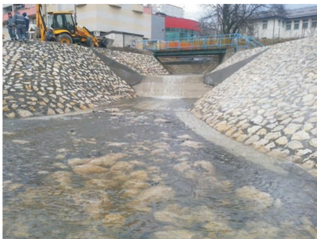
Slika 3 – Žepče ušće r. Krajnjače, nakon radova
