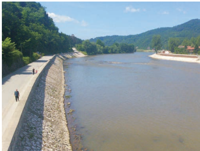
Slika 5 – Maglaj, uzvodno od mosta nakon radova
