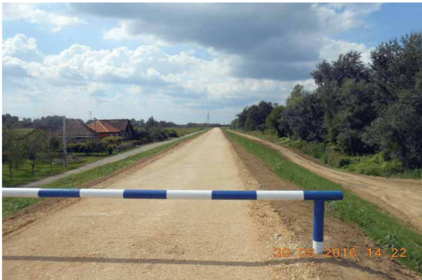
Slika2. Rekonstruisani nasip u Tursinovcu
