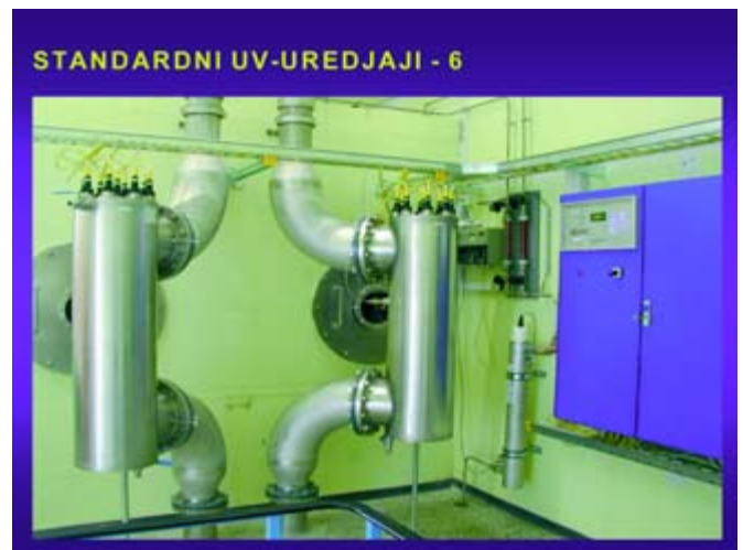
Slika br. 7 - Montirani UV uređaj
