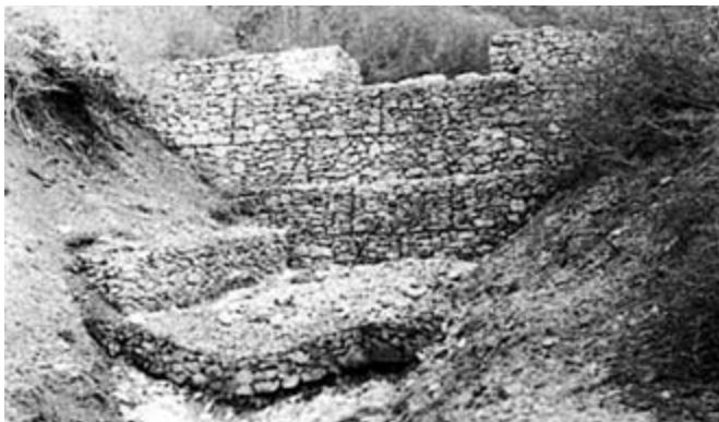
Sl. 10 - Gabionska pregrada sa podslapljem u bujici “Kokošiji dolac” (desna pritoka akumulacije Rama)
