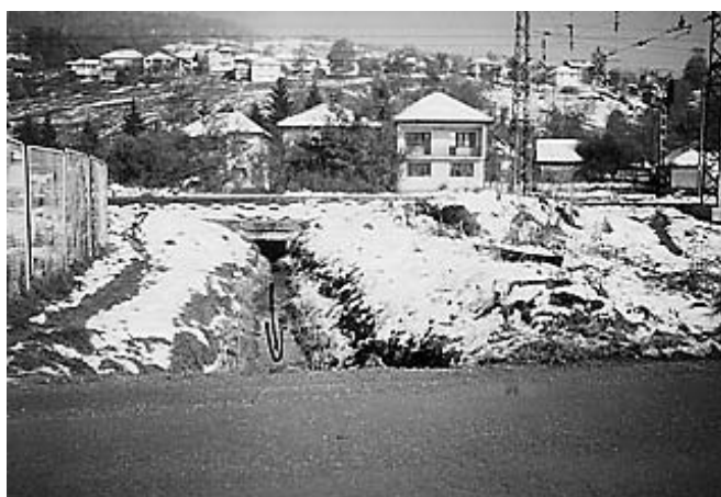
Slika 4. – Propust br. 8 (Propust ispod pruge)
