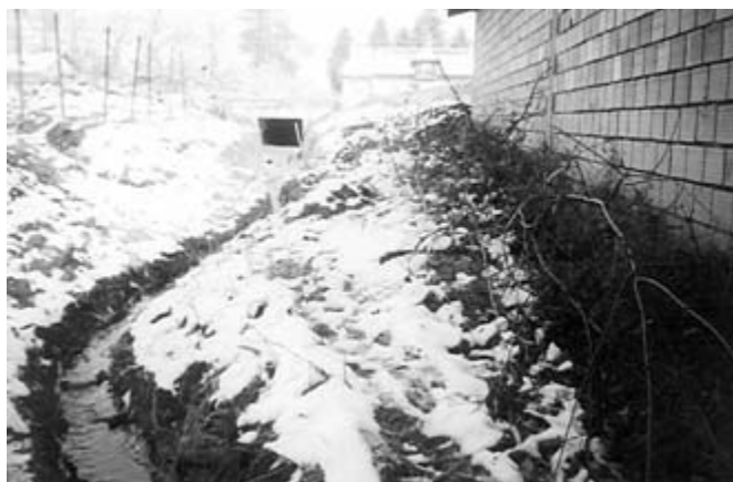
Slika 2. – Propust br. 6 (Propust ispod pruge)
