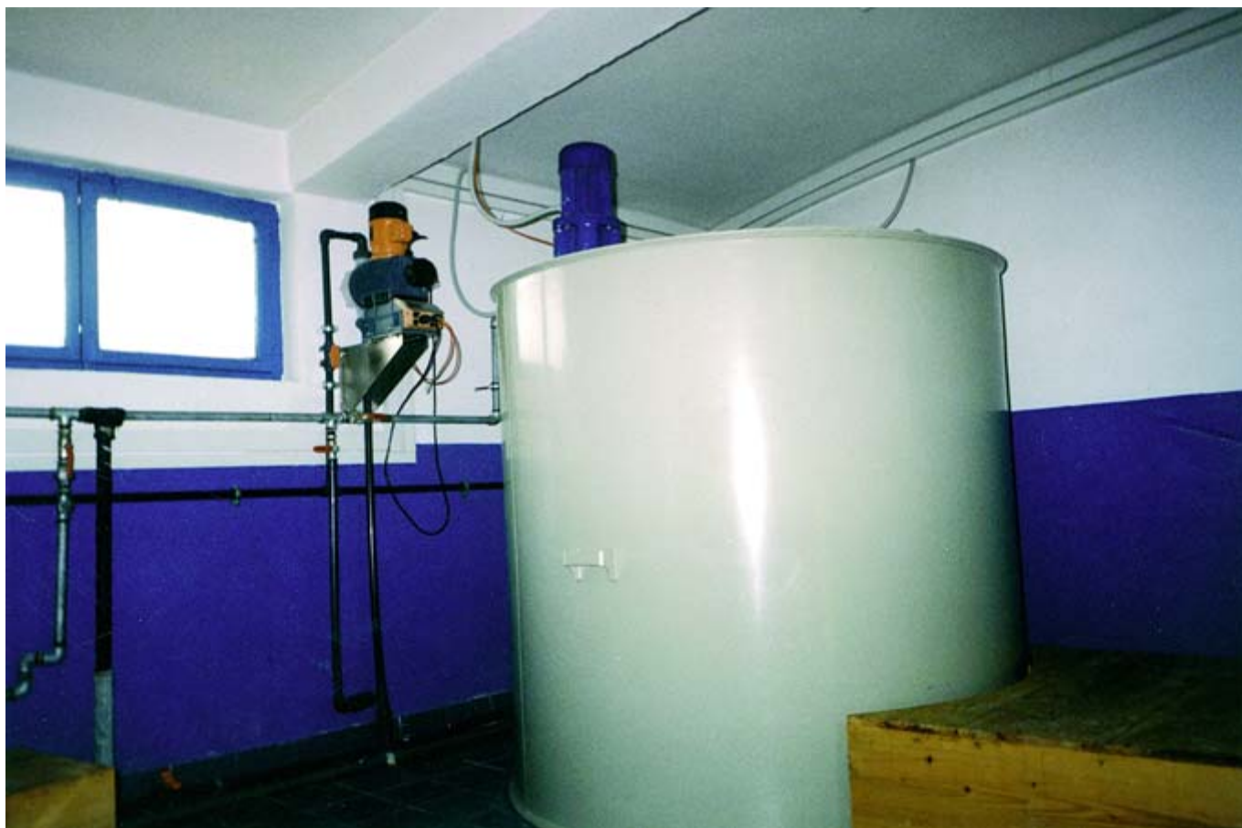
SL. 7 - PLASTIČNA POSUDA ZA PRIPREMU RASTVORA KOAGULANTA
