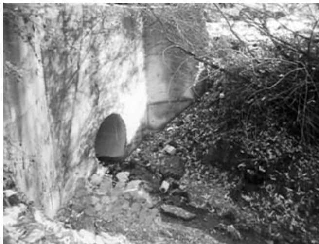
Slika 3. – Ispust br. 2 (Postojeći ispušt)
