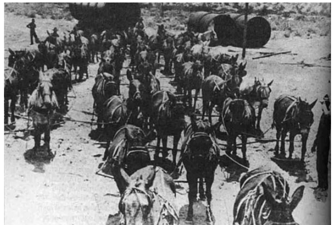
U vrijeme izgradnje L.A. Akvadukta mule su bile glavna "mehanizacija"
