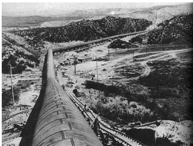
Dionica L.A. Akvadukta kroz pustinju Mojave - snimak neposredno po izgradnji
