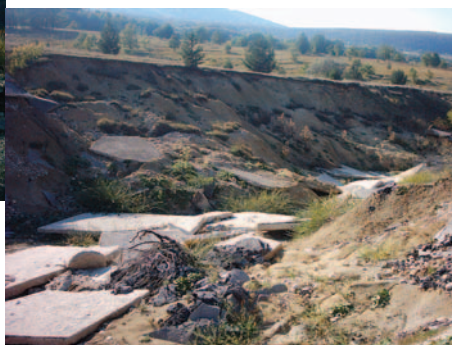
Župica preliv, devastirani brzotok na prelivu i devastirana Bučnica
