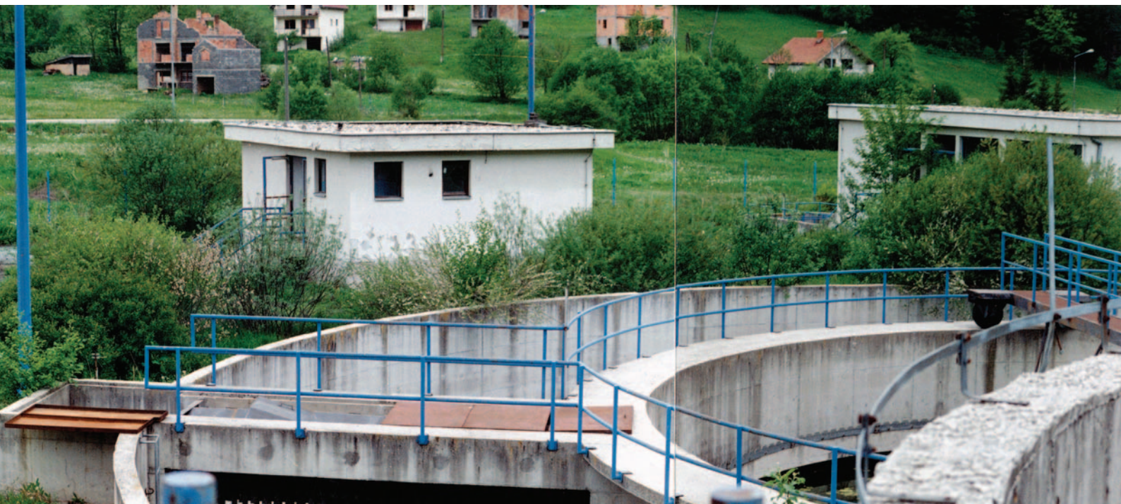
Još jednom postrojenje u Trnovu - pogled na nekadašnju upravno-pogonsku zgradu i objekat bioaeracionog bazena sa naknadnim taložnikom
