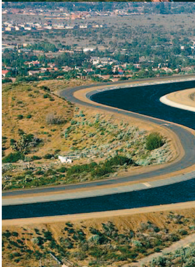
Kolorado River akvadukt
