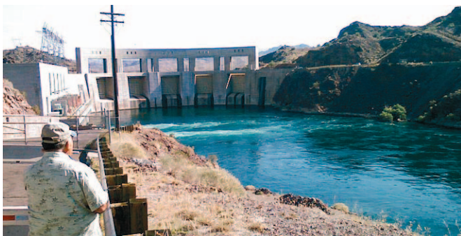
Parkerova brana sa zahvatom vode za Kolorado River akvadukt
