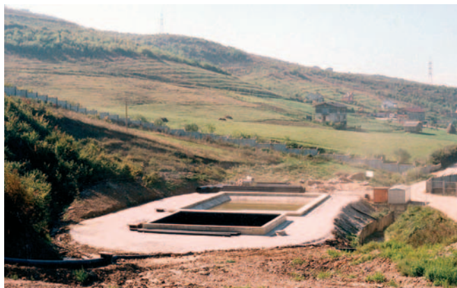
Slika 4. Bazeni za filtrat i oborinsku vodu
