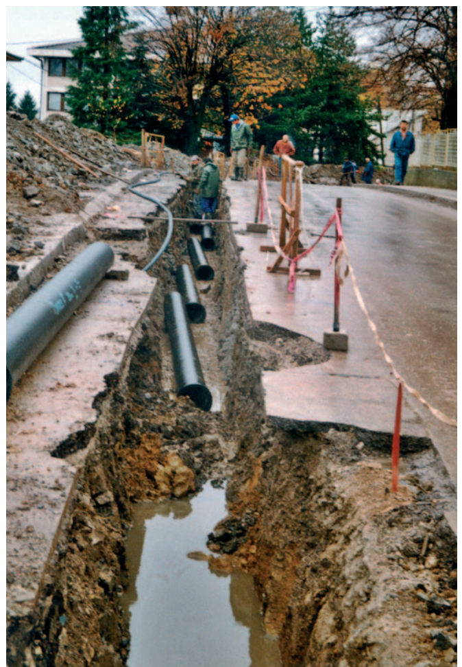
Polaganje kanalizacionih cijevi
