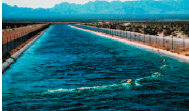
Kolorado River akvadukt
