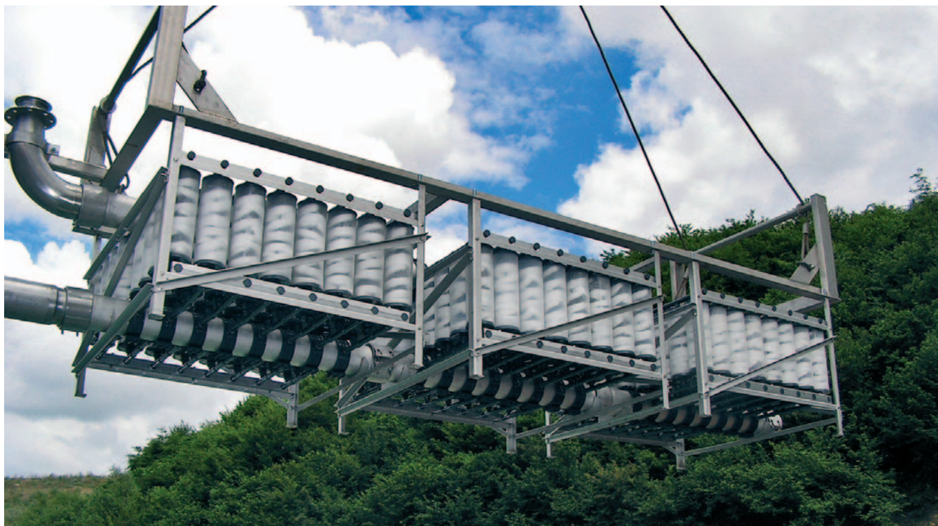
Slika 8. Faze monataže i postavljanja kompleta modula u bazen
