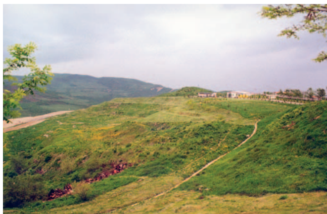
Slika 2. Čelo odlagalište poslije sanacije
