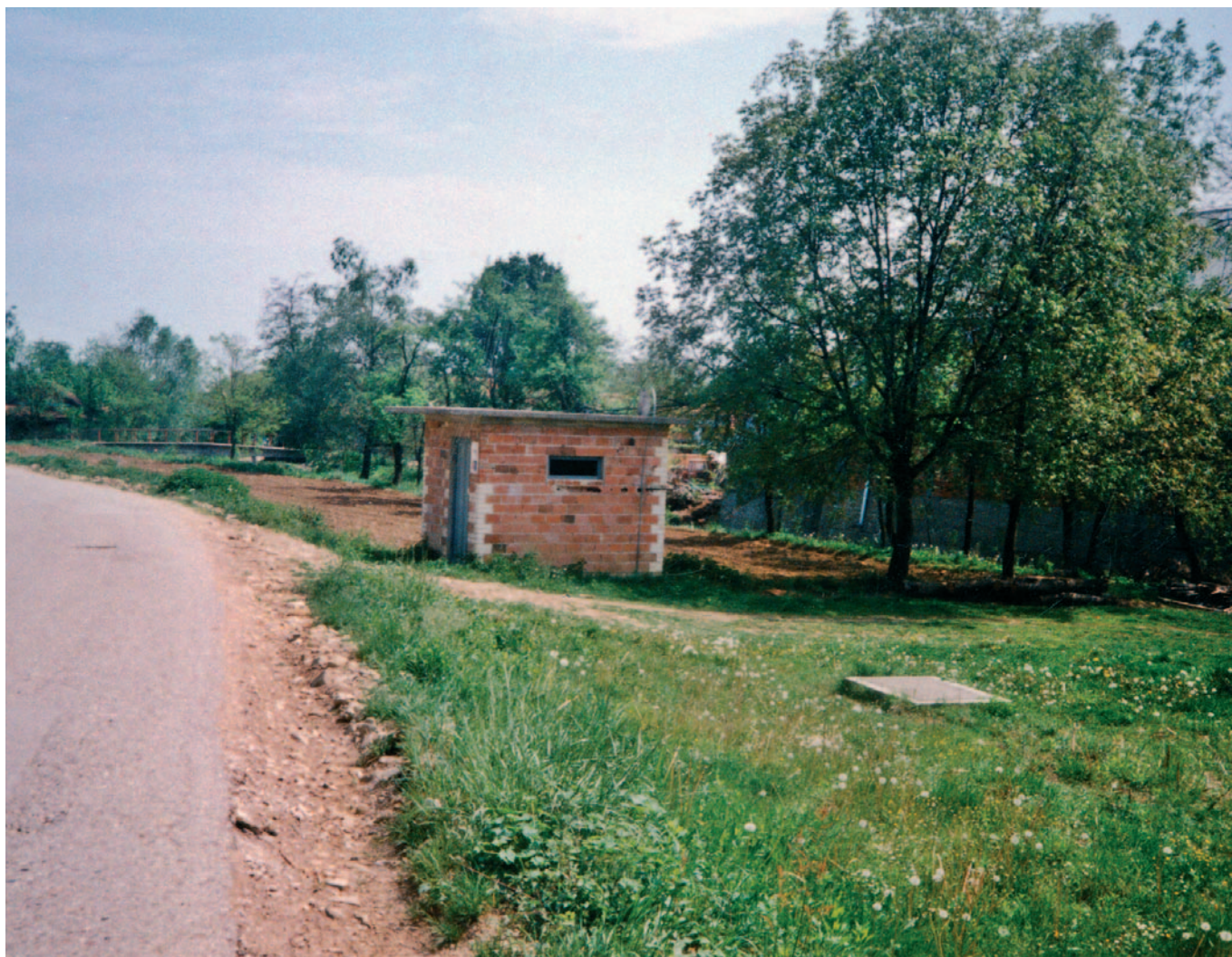
Bunar za vodu se štiti izgradnjom kanalizacione mreže
