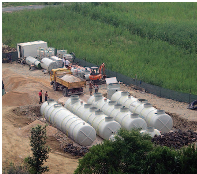
Sl. 4. Ugradnja SBR_REG_1000 Crna Gora
