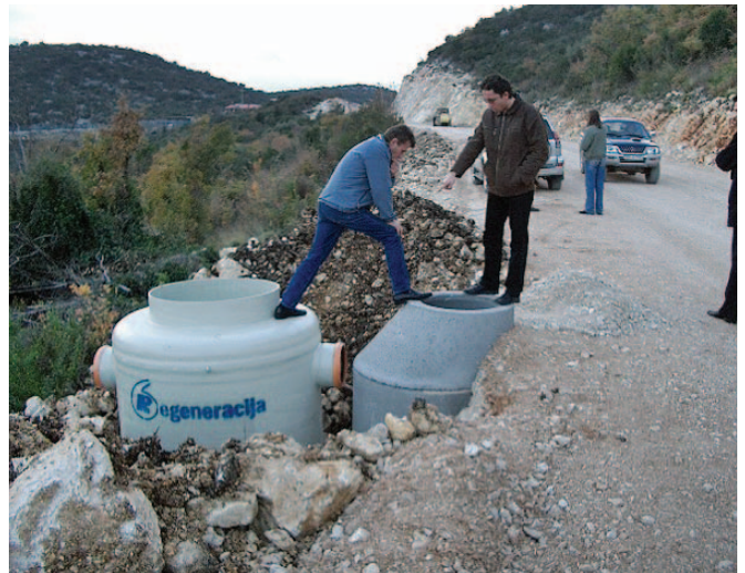
Sl. 8. Ugradnja uređaja za oborinske vode Vodozaštitna zona-Neum
