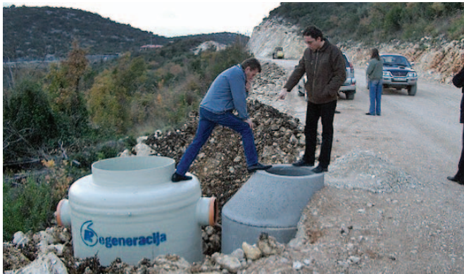
Sl. 9. Ugradnja uređaja za oborinske vode Mostovi-koridor VC
