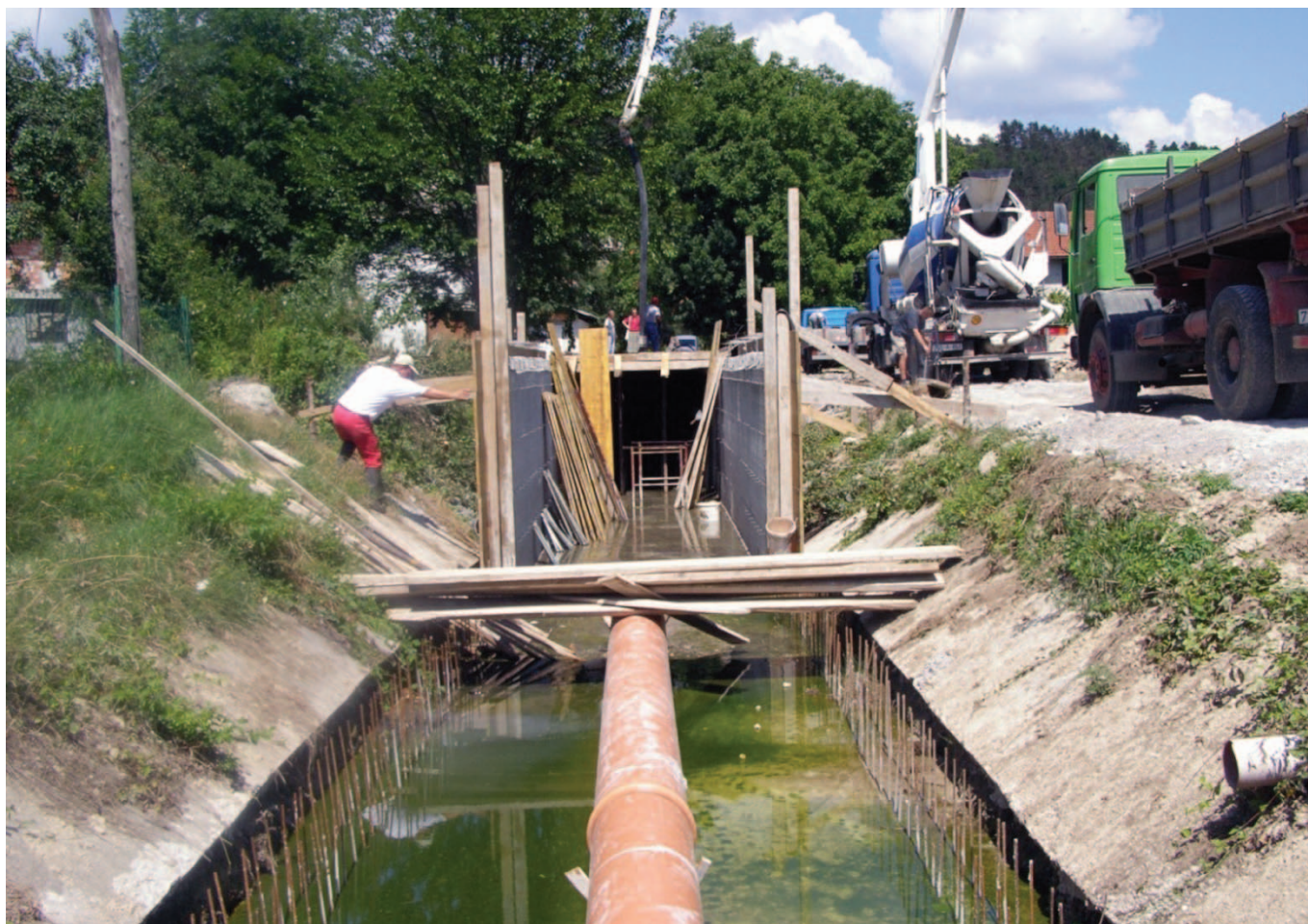
Izrada zatvorenog profila korita potoka Kalender, općina Bosanska Krupa, juli, 2008.
