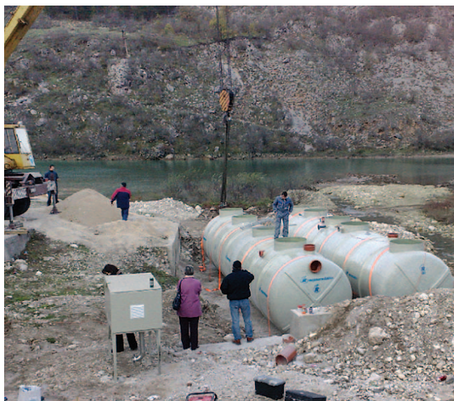
Sl. 5. Ugradnja SBR_REG_400 Glogošnica-Jablanica
