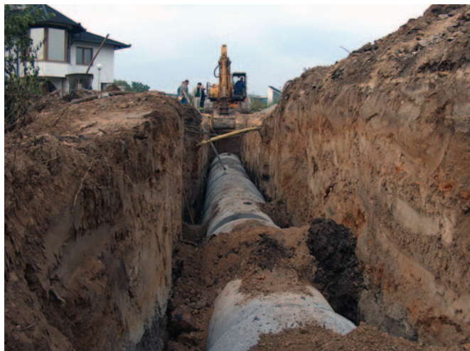
Izgradnja kolektora Repušine AO u općini Bihać, septembar 2005.
