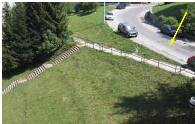
Slika 2. Nakon opravke vodovodne cijevi više nema vode na asfaltu niti krtičnjaka na suhom travnjaku (strelica pokazuje suhi asfalt)
