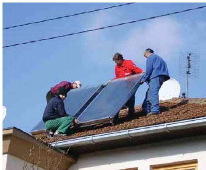
Montaža izrađenih kolektora na jedan od odabranih stambenih objekata u Gradačcu
