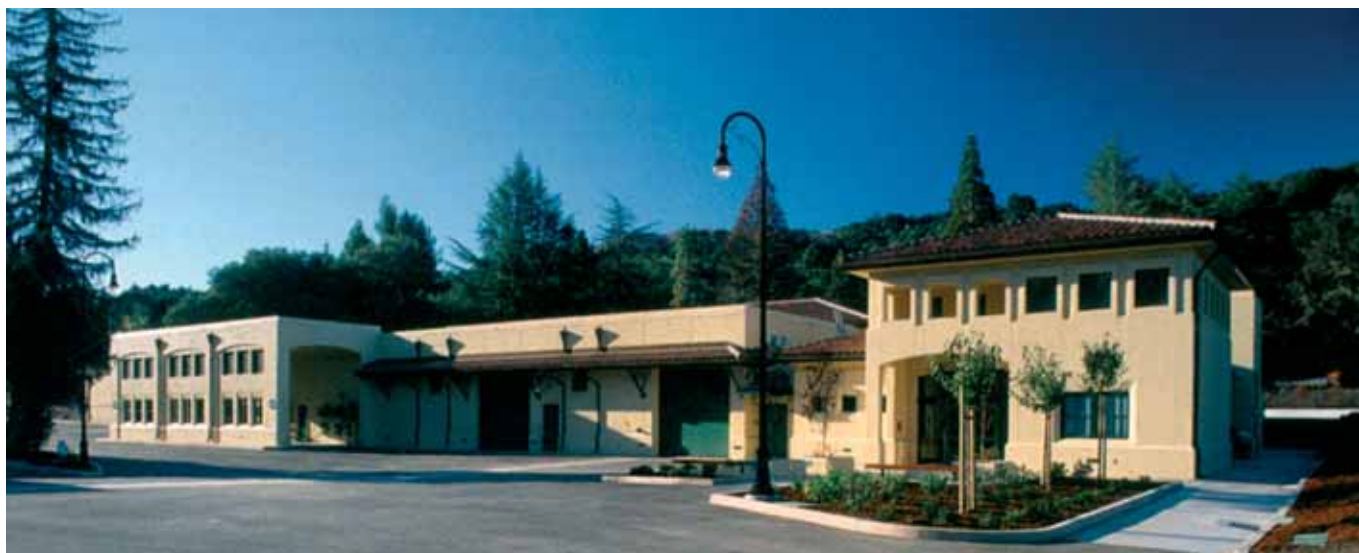
Renovirano postrojenje za prečišćavanje u Orindi
