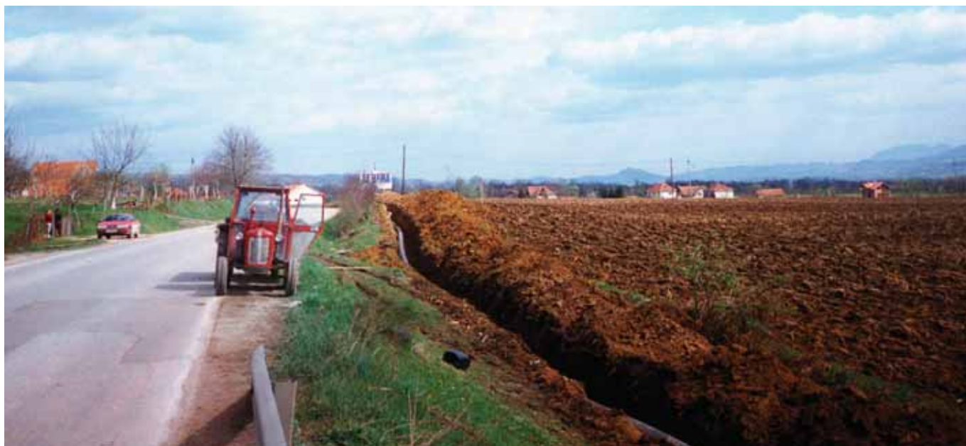
Njive ponekad služe i za manje građevinske poslove – polaganje cjevovoda za vodosnabdijevanje u Kalesiji
