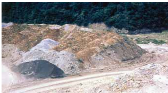
Sl. 4. Krovinsko jalovinski materijal se često sastoji iz pjeskovitih geoloških slojeva. Važno je kod izbora rekultivacije da se na površinu odloženog materijala mora nanositi poseban sloj prirodnog tla ili povoljnog krovinskog materijala.
