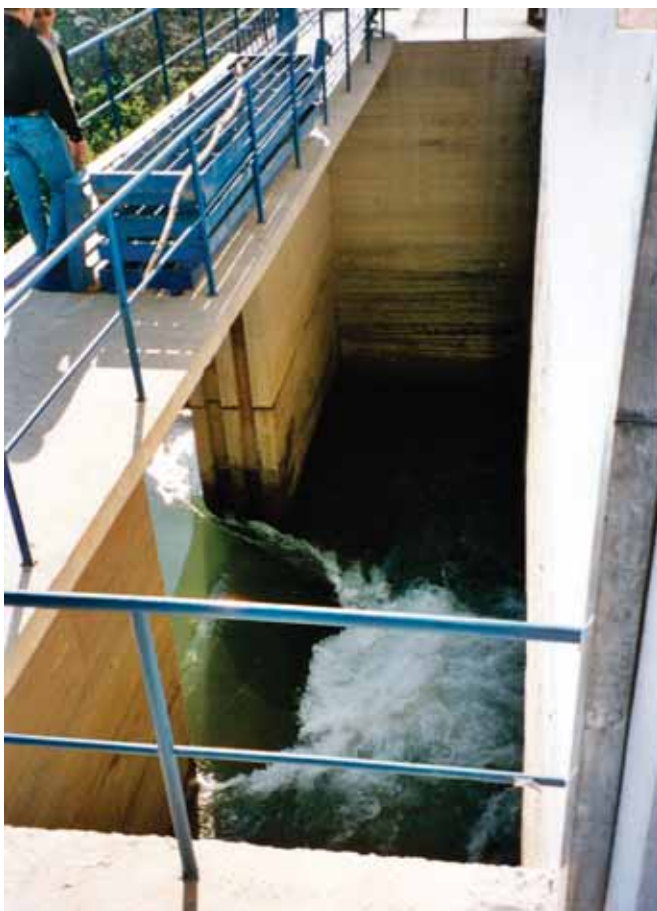
Ustava na kanalu Drina-Dašnica
