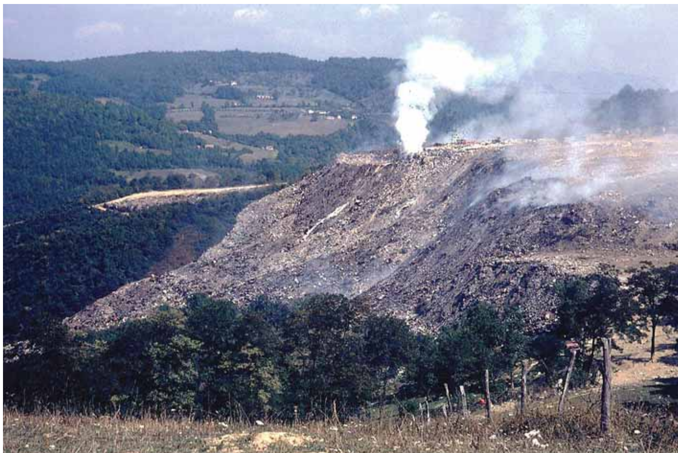
Sl. 11. Sarajevo – Buća Potok – komunalno odlaganje smeća usljed nepovoljnih svojstava zahtijeva indirektnu rekultivaciju. Potrebno je nanositi cca 40-50 cm povoljnog površinskog sloja.
