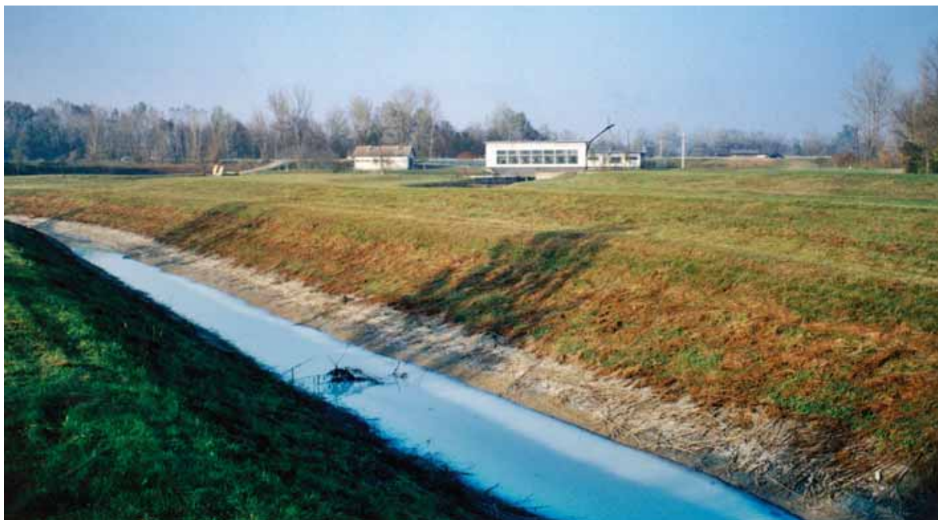
Kanal Drenovac kod Orašja, za odvodnju u plodnoj Posavini
