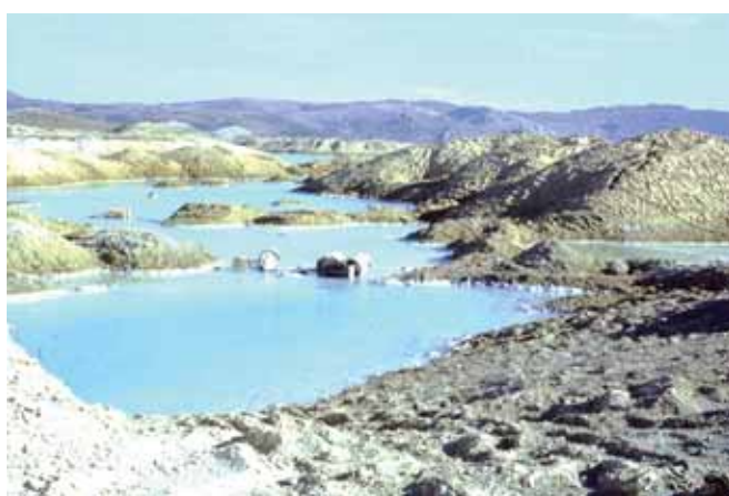
Sl. 6. Gacko – odlagalište pepela i šljake dovodi pored isključenja zemljišta iz proizvodnje i do uništavanja okolne vegetacije. Usljed raznošenja suhog pepela ovdje je nužno izvesti indirektnu rekultivaciju.
