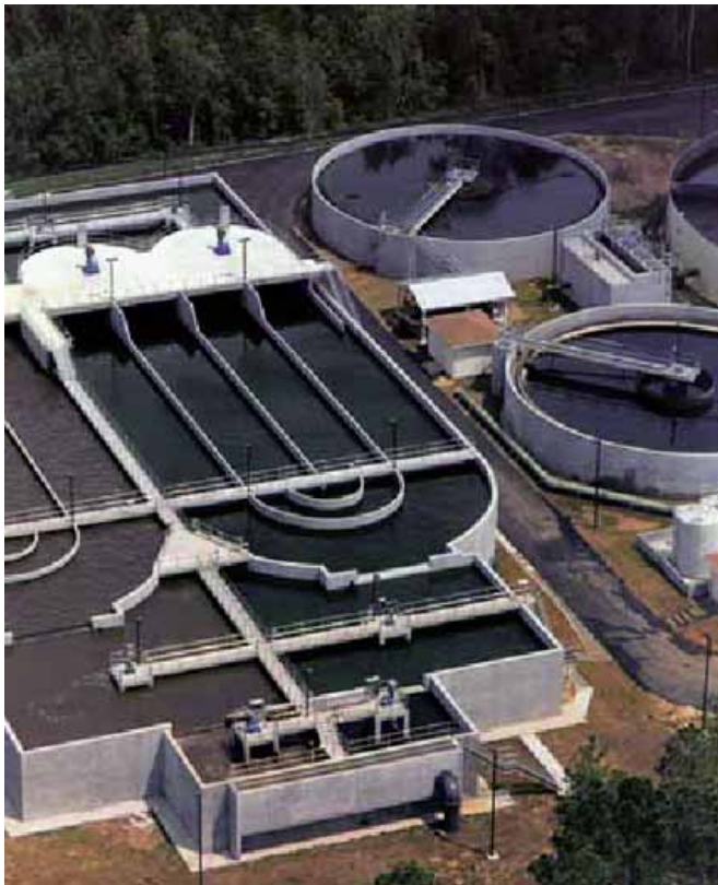
Slika 1 – Postrojenje sa Carrousel postupkom
