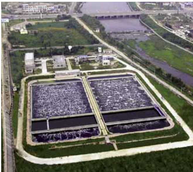
Slika 4 - Postrojenje sa Biolac postupkom
