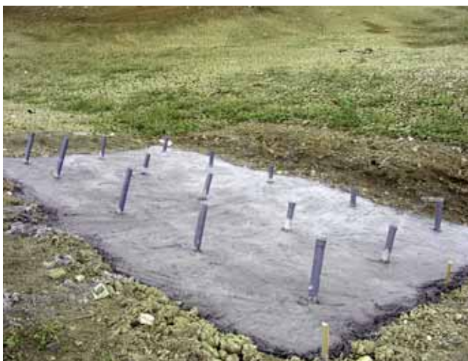
Slika broj 3. Završetak injekcione faze br.1.
