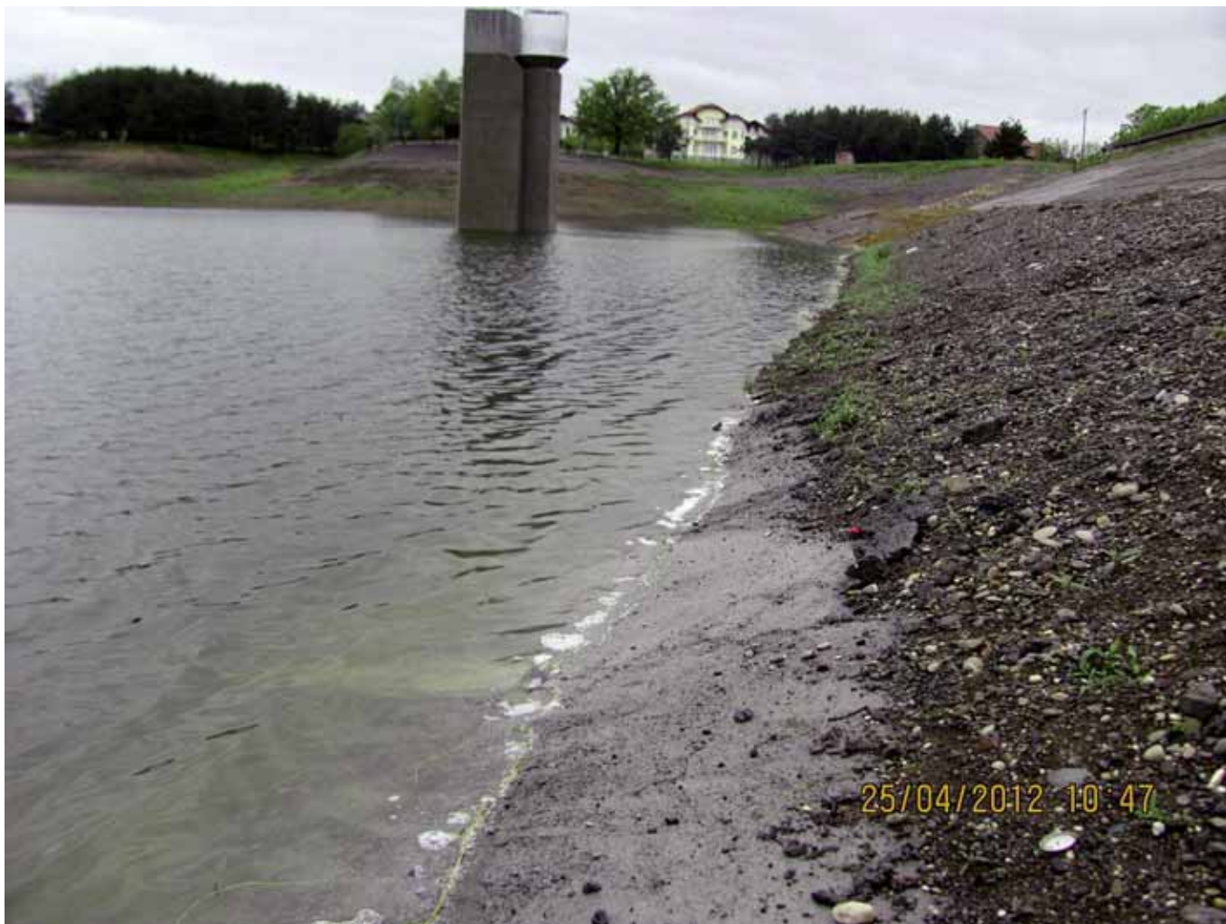
Slika broj 5. Injekcijska zavjesa je djelimično pod jezerskom vodom
