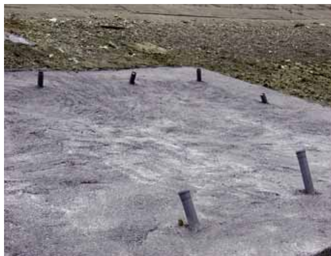
Slika broj 4. Završetak 2. faze injektiranja
