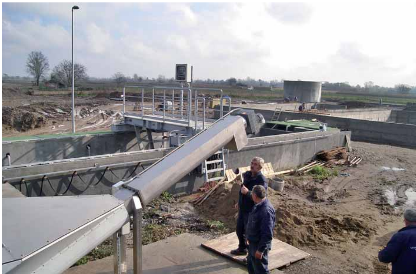
Faza u izgradnji uređaja za tretman komunalnih otpadnih voda u Odžaku
