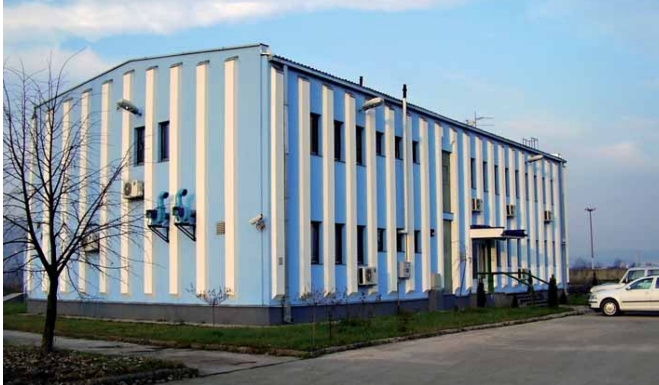
Zgrada vodoprivredne laboratorije u Butilama kod Sarajeva
