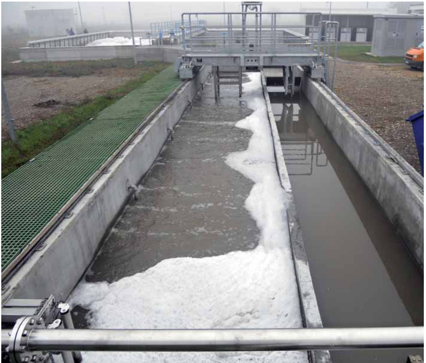
Pjeskolov na uređaju za tretman komunalnih otpadnih voda u Odžaku
