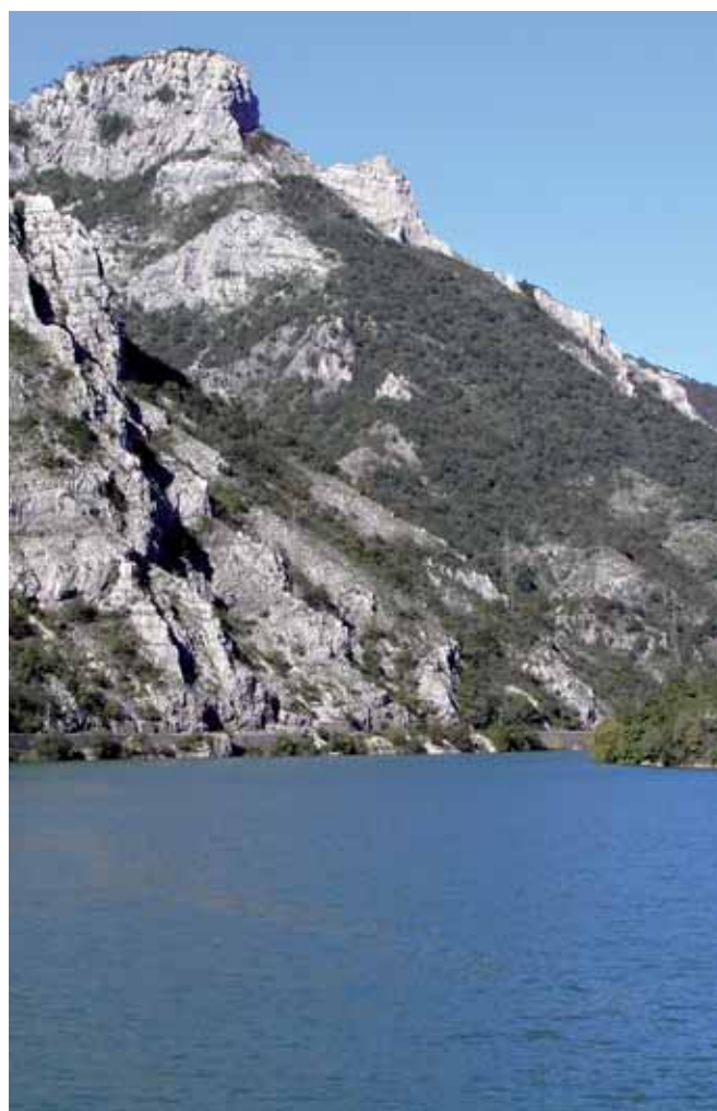
Nizvodni pogled na Jablaničko jezero
