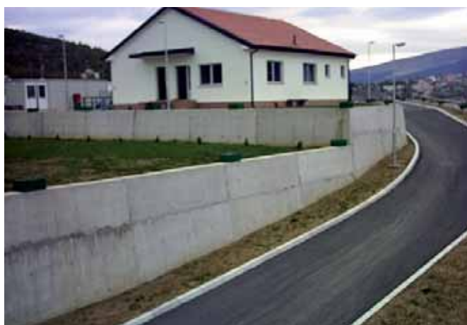
Slika 6. Potporni zidovi u krugu postrojenja
