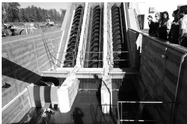
Grube rešetke i pužne pumpe
