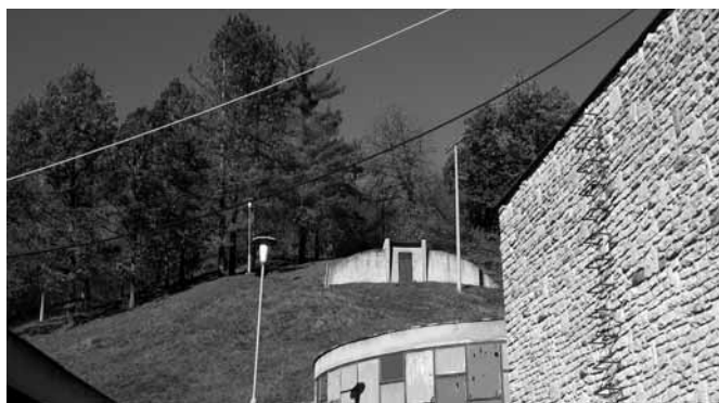
Pogled na rezervoar Stupari
