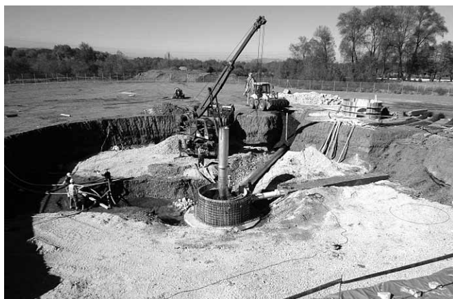
Postrojenje u fazi izgradnje naknadnog taložnika
