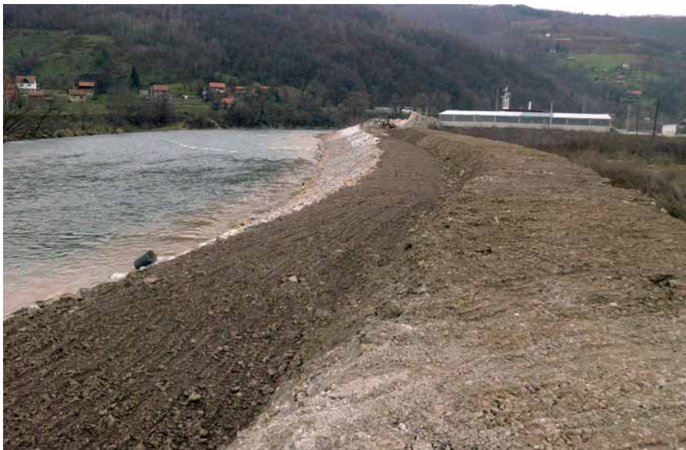
Rijeka Bosna, Begov Han – nakon izvedenih radova
