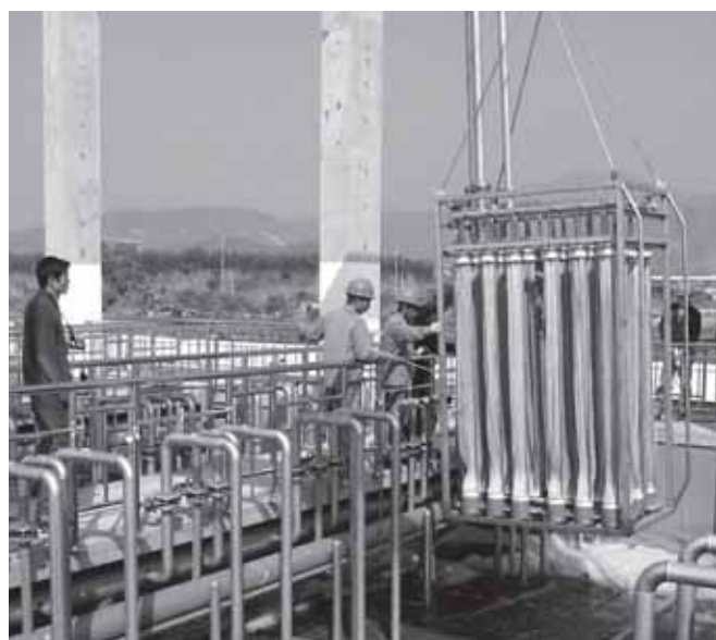
Slika 4 – Postavljanje membranskog modula u bioreaktor
