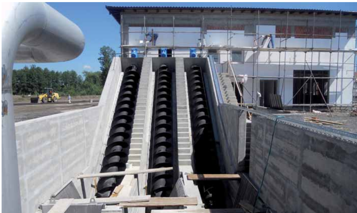
Izgradnja uređaja za tretman otpadnih voda u Živinicama – pužne pumpe
