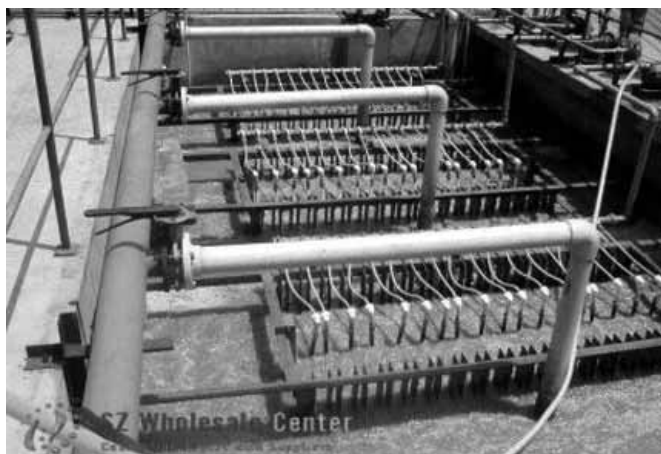
Slika 5 – Potopljeni membranski moduli u bioreaktoru
