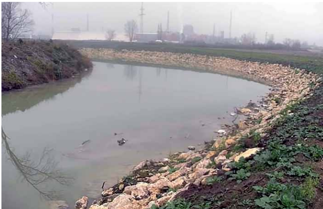
Rijeka Spreča, Lukavac – nakon izvedenih radova
