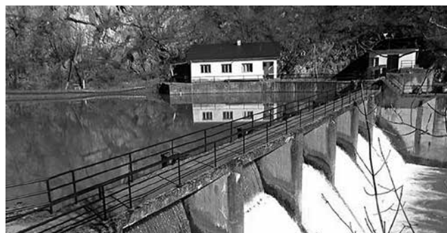
Slika 12. Brana hidroelektrane Mesići na rijeci Prači kod Rogatice. Puštena je u rad 1950. godine kao prvi elektroenergetski objekat ove vrste izgrađen u poslijeratnoj Jugoslaviji. HE Mesići u optimalnim hidrološkim prilikama proizvodi oko 15.500.000 KWh godišnje
