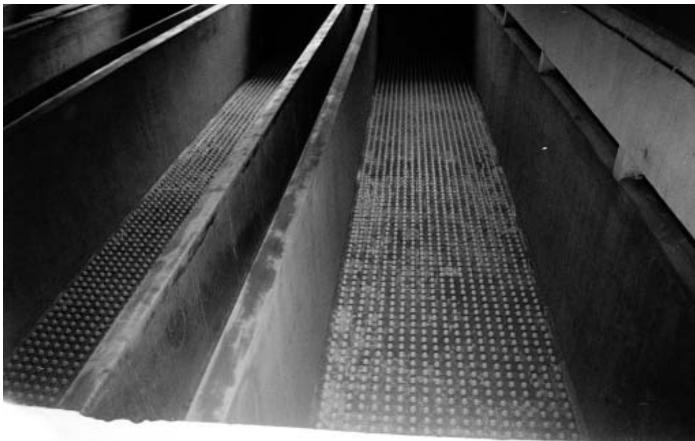
Slika br 8. Izgled filterskog dna sa diznama
