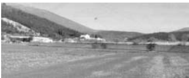
Slika 9: Objekat bočnog preliva na prvom sektoru ekspanzije površine
