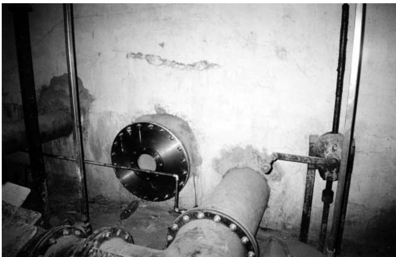
Slika br. 9 Izgled revizionog okna-manloha
