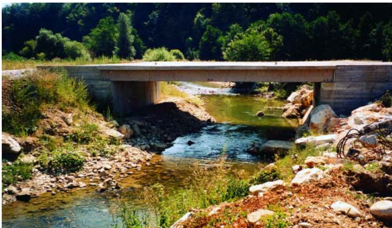
Most nedovoljnog kapaciteta na r. Biloj u Vitezu, avgust 2003.
