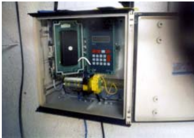
Na fotografiji je prikazan izgled automatske stanice smještene u obnovljeni objekat.
