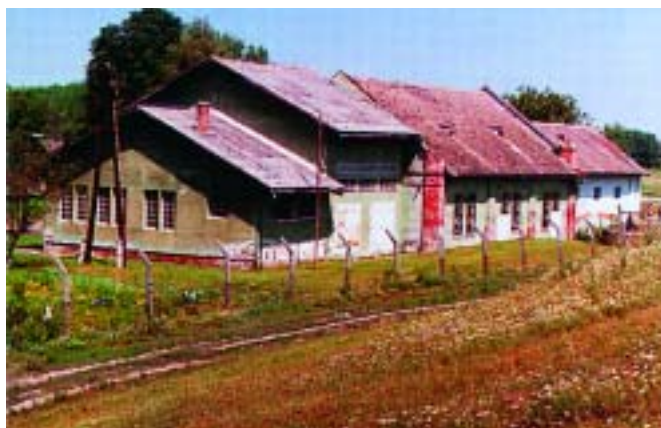
Crpna stanica "Zlatna greda" prije obnove ...
