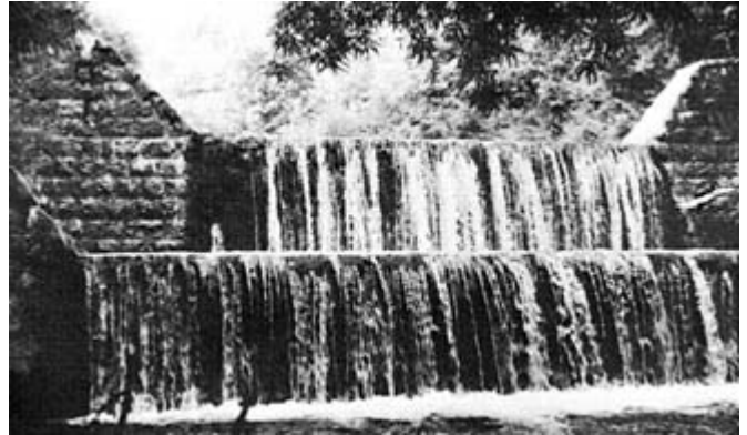
Sl. 2: Deponiska pregrada od kamena u cementnom malteru u bujici "Bijela" (lijeva prit oka r. Neretve)
