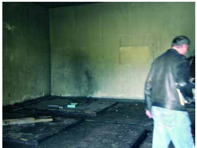
Slika 8. Prostorija u kojima su se nalazili transformatori u vojnom objektu na Jahorini
