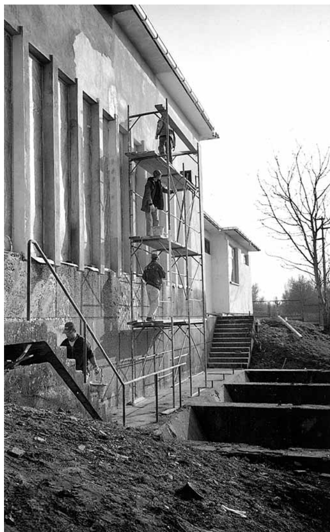
Rekonstrukcija crpne stanice Đurići na području Brčko Distrikta uz rijeku Savu je u fazi završavanja
