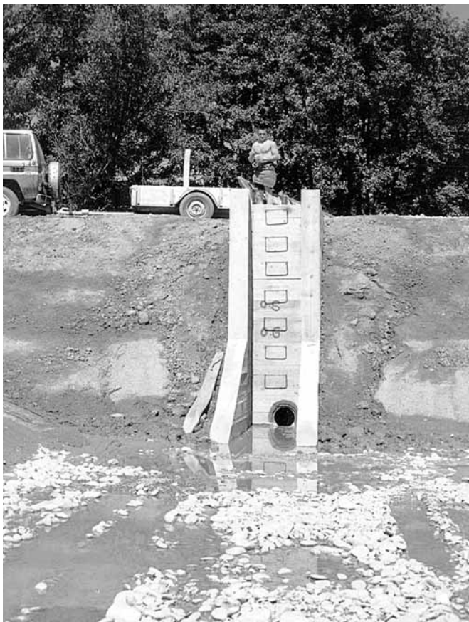
Detalj uređenja nasipa sa ispustom na r. Savi
