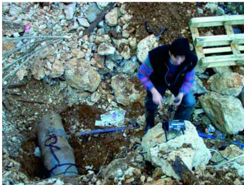
Slika 9: Donja zona – Montaža ultrazvučnog mjerača protoka na cijev
