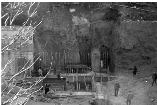
Temeljenje na kontraforima prag 8
