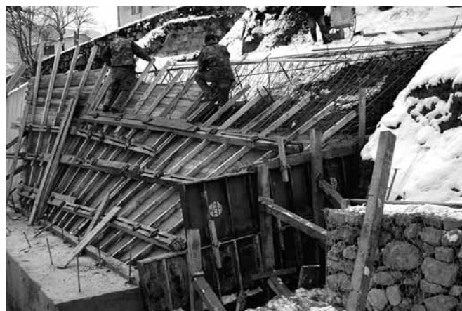
Betoniranje krilnih zidova
