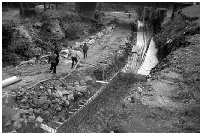
Temeljenje obalnih AB zidova
