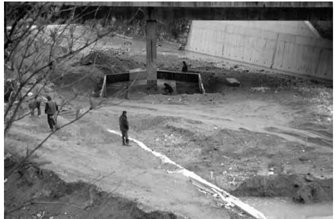
Sanacija i zaštita upornjaka mosta
