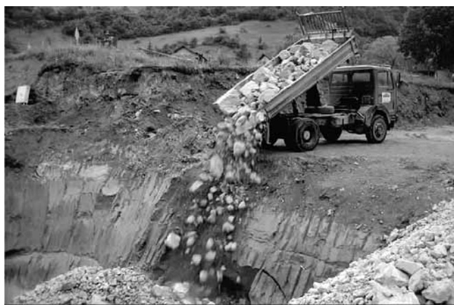
Zamjena slabonosivog dobronosivim materijalom
