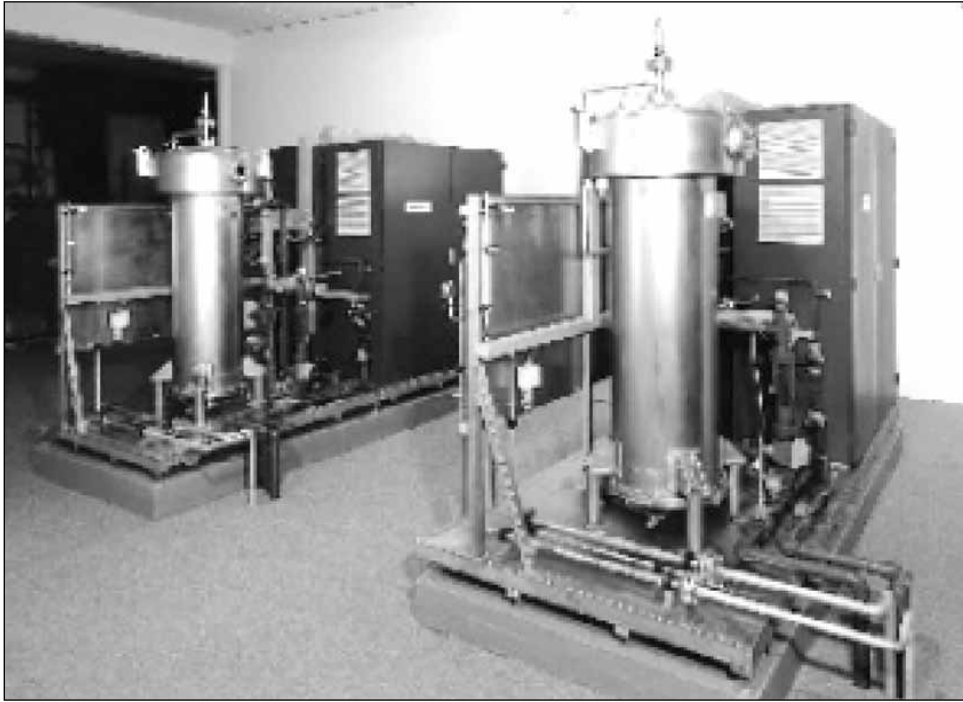
Sl. 13. Ozonske jedinice na Postrojenju za pitku vodu "Am Staad" grad Dizeldorf, Njemačka
