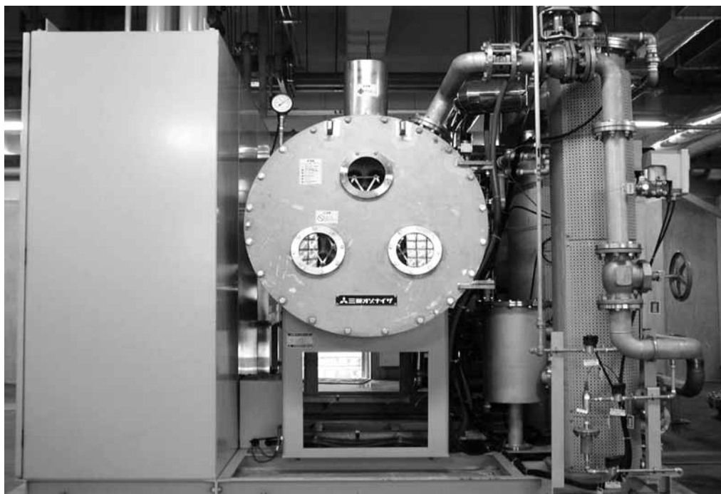
Sl. 3. Izgled Wedeco ozon generatora
