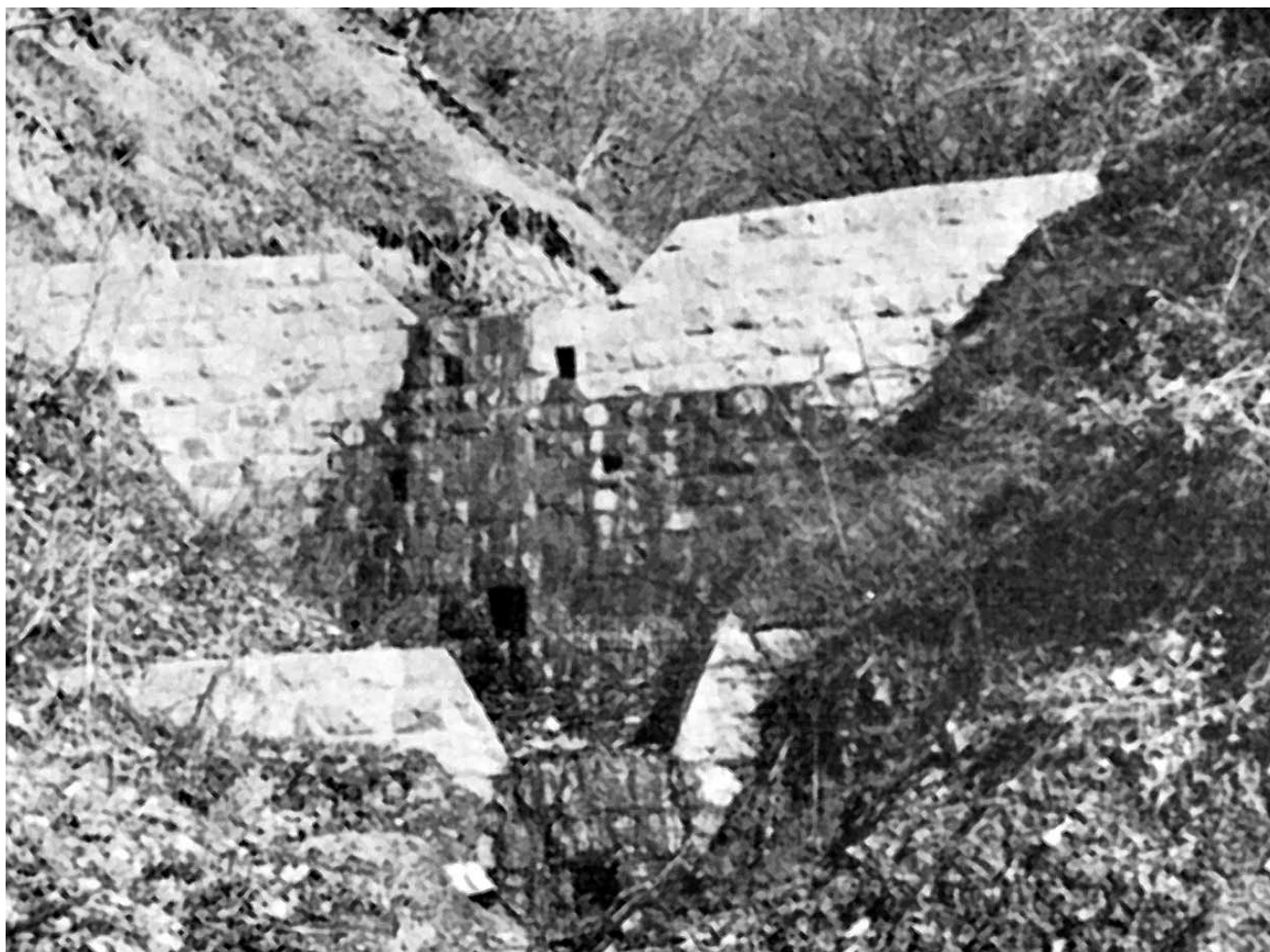
Sl.3 Konsolidaciona pregrada koja je u izvjesnoj mjeri zaustavila snažne pokrete obalskih padina u svom uzvodnom djelovanju
