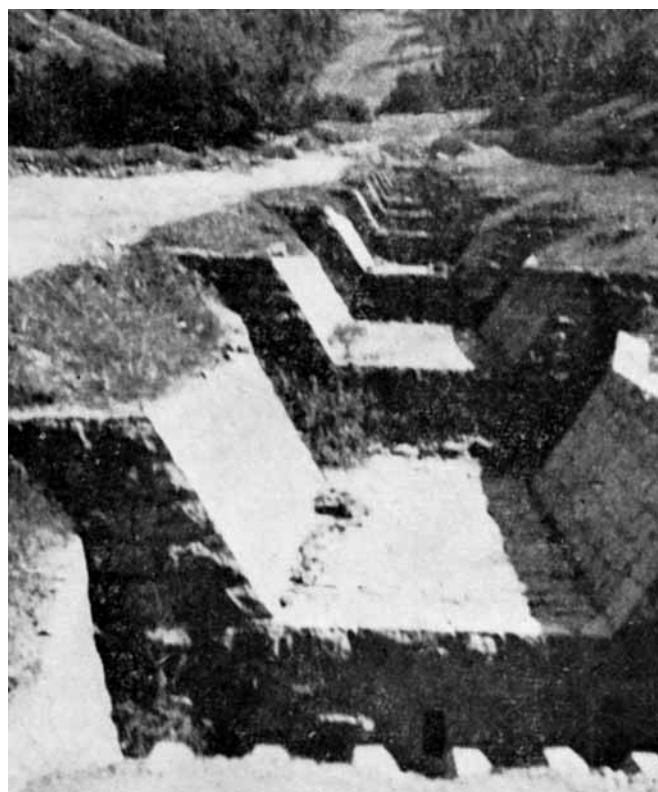
Sl.2 Pravolinijska kineta sa kaskadama u koritu jednog bujičnog toka
