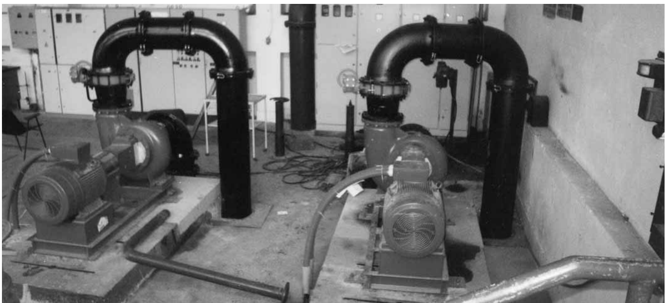
Domaća pumpna stanica u rekonstrukciji
