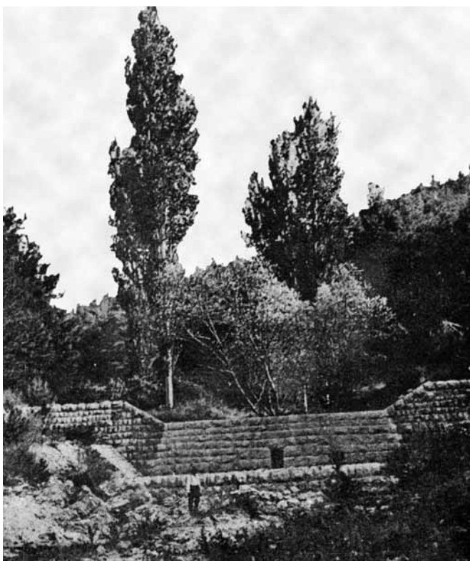
Sl. 5 Pregrada od kamena u cementnom malteru na području krša
