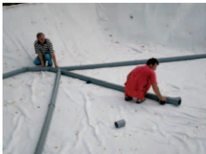
Postavljanje drenažnih cijevi
