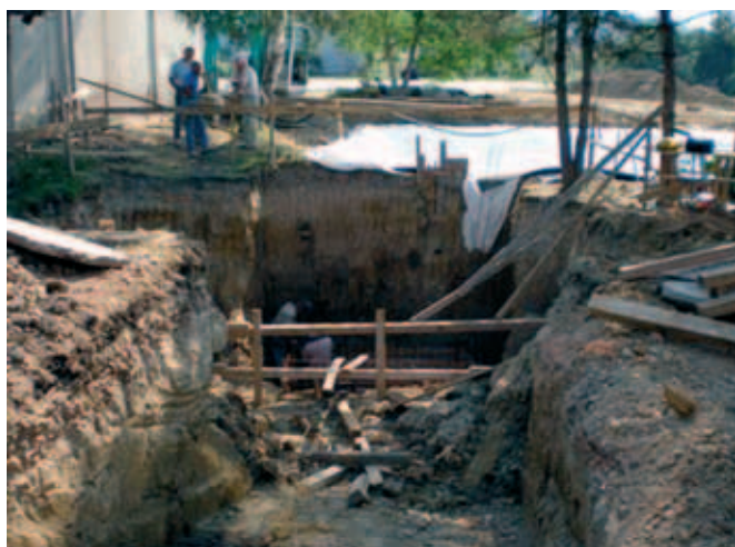
Iskop za kompostirajući separator
