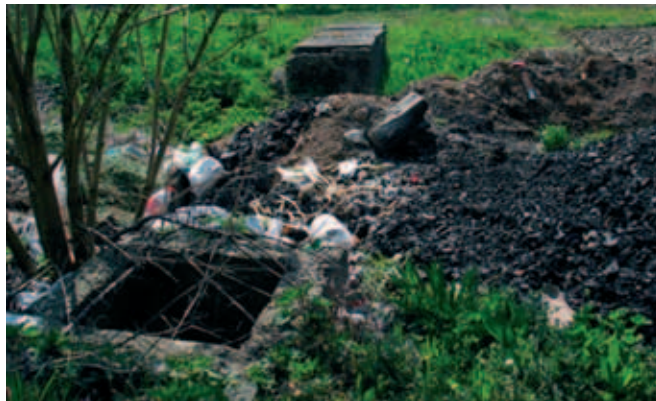
Pogled na stari šaht i septičku jamu iz koje je voda ponirala u tlo
