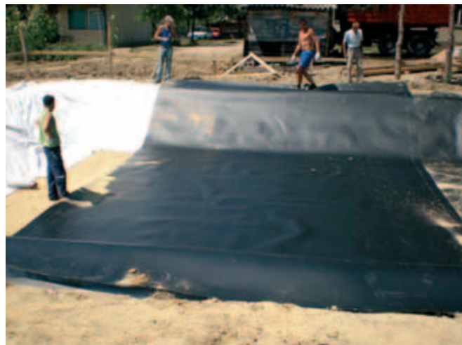
Postavljanje nepropusne folije u filterskoj lijehi
