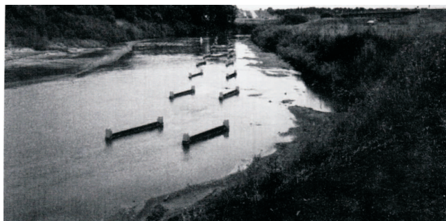
Slika 3: Izvedeni usmjerivači toka na vodotoku East Nishnabotna, Iowa, SAD
