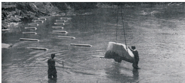
Slika 4: Ugradnja prefabrikovanih elemenata usmjerivača toka u SAD-u
