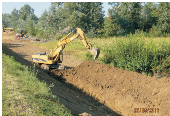
Slike 6. i 7. Iskop zemljanog materijala i priprema terena za ugradnju „Glinenog čepa“ na dionici Kopanice - Vidovice
