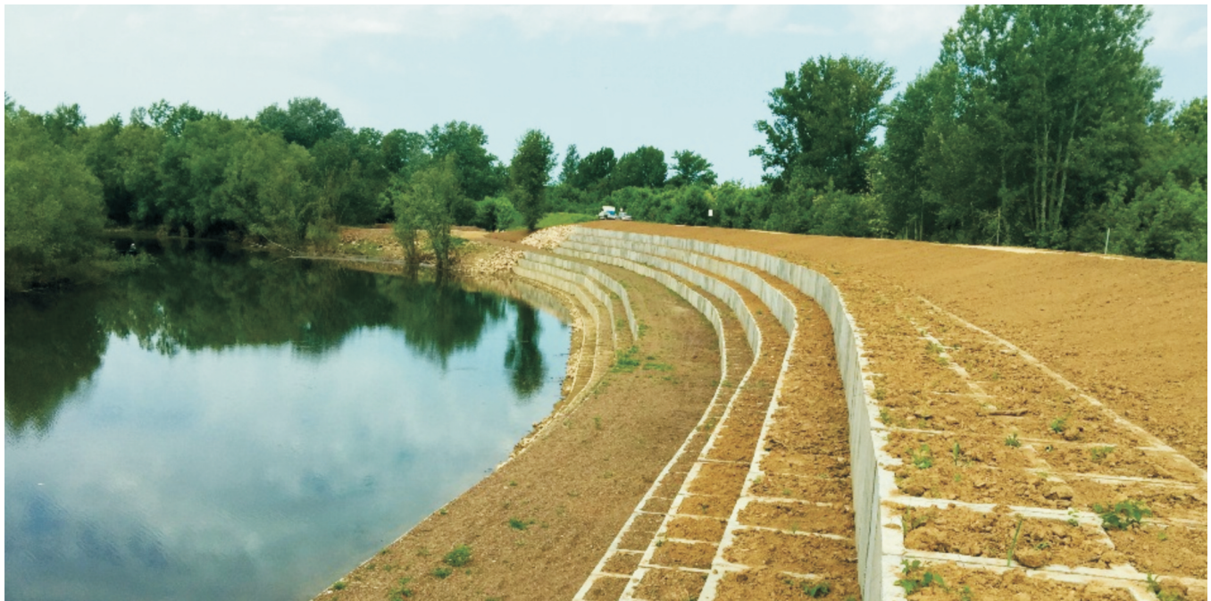
Slika 3. Rekonstruisani bosanski odbrambeni nasip na lokalitetu „Labudova krivina“ – nožica i kosina nasipa obloženi betonskim gabionima
