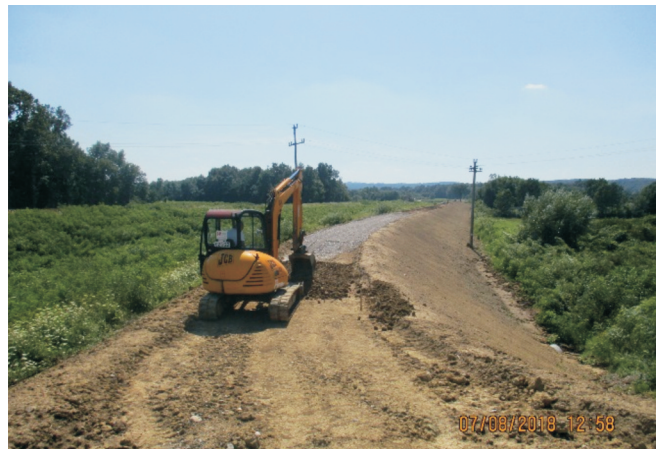
Slike 4. i 5. Planiranje kosina nasipa i posteljice kolovoza te izrada šljunčanog kolovoza na kruni nasipa – lokalitet obodnog kanala Svilaj-Potočani
