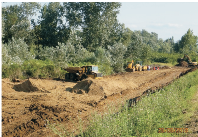
Slike 6. i 7. Iskop zemljanog materijala i priprema terena za ugradnju „Glinenog čepa“ na dionici Kopanice - Vidovice
