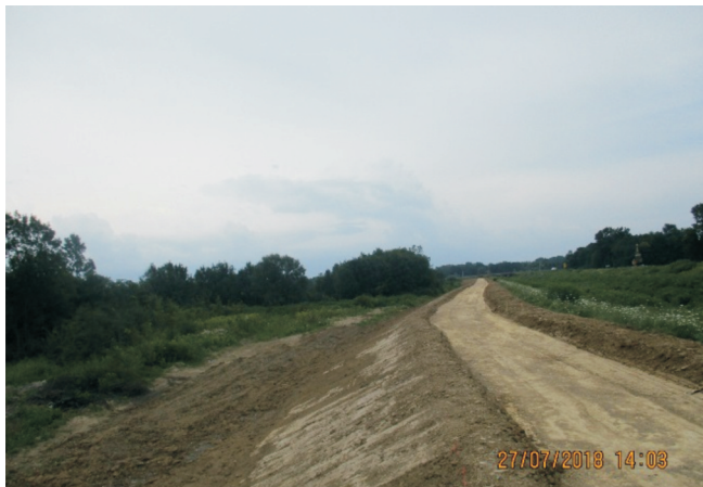
Slike 4. i 5. Planiranje kosina nasipa i posteljice kolovoza te izrada šljunčanog kolovoza na kruni nasipa – lokalitet obodnog kanala Svilaj-Potočani
