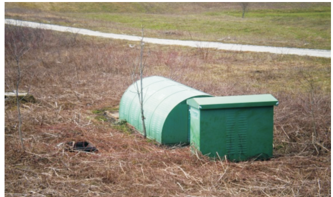
Sl. 9. Vanjski izgled septika GP Izačić (foto V. Franjić)
