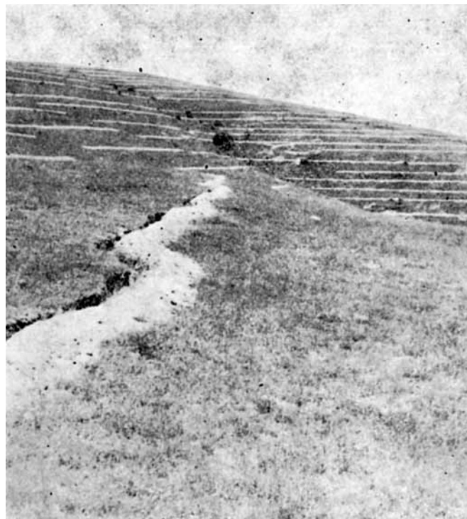
Slika 2: Konturne brazde na pašnjaku neposredno poslije izrade
