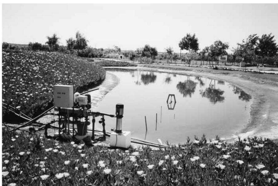
Aerobna laguna u Sevilli (CITET)
