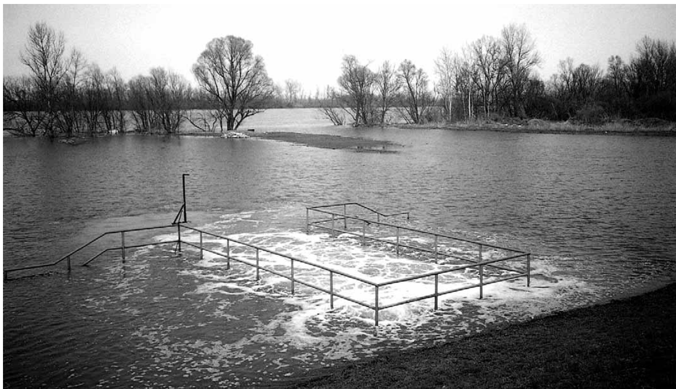
Na Crpnoj stanici Zorice II - u toku pumpanje za odvodnju viška voda
