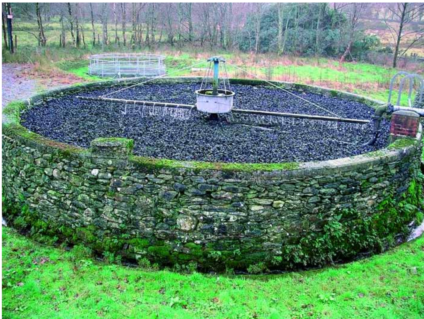
Slike: primjena plastičnih medija kod trickling filtera Beddgelert
