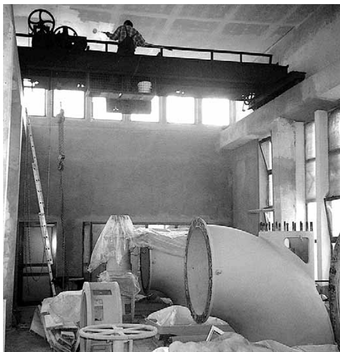
Detalj sa rekonstrukcije Crpne stanice Đurići
