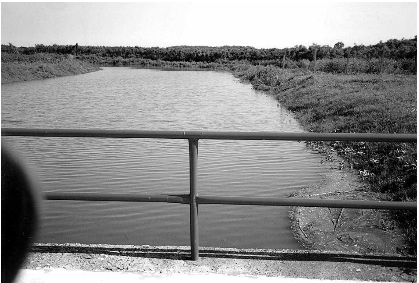
Dovodni kanal na CS Zorice
