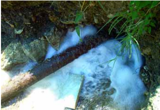
Slika 7: Otkopavanje kvara – Gornja Rivijera – Herceg Novi
