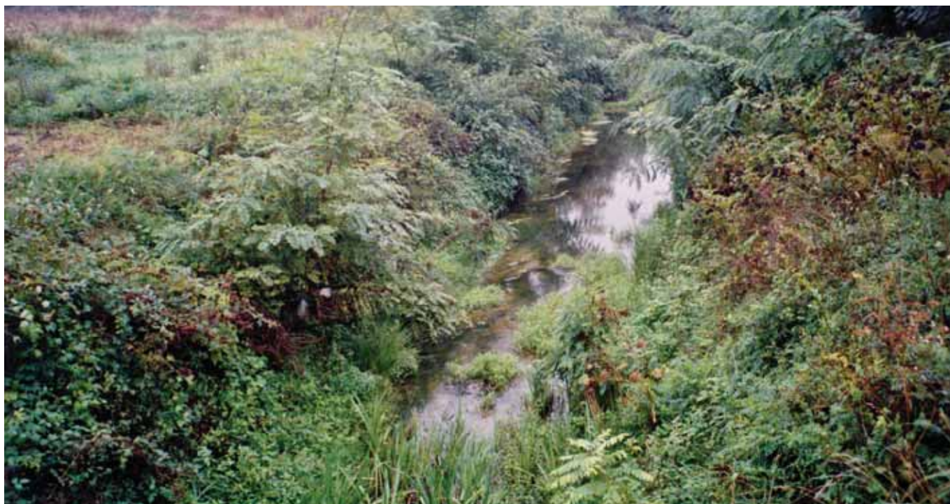
Kanal za odvodnju u Posavini obrastao zelenilom
