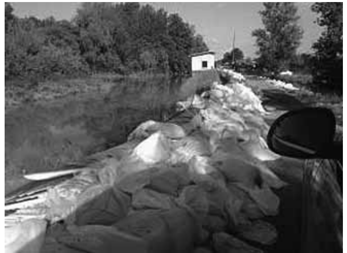
Foto 3: Aktivnosti na izgradnji druge odbrambene linije i nadvišenja nasipa
