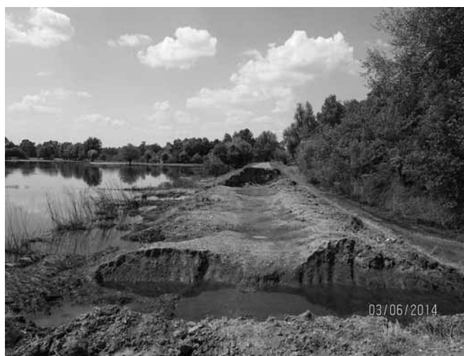
Proboji na savskom odbrambenom nasipu u Prudu
