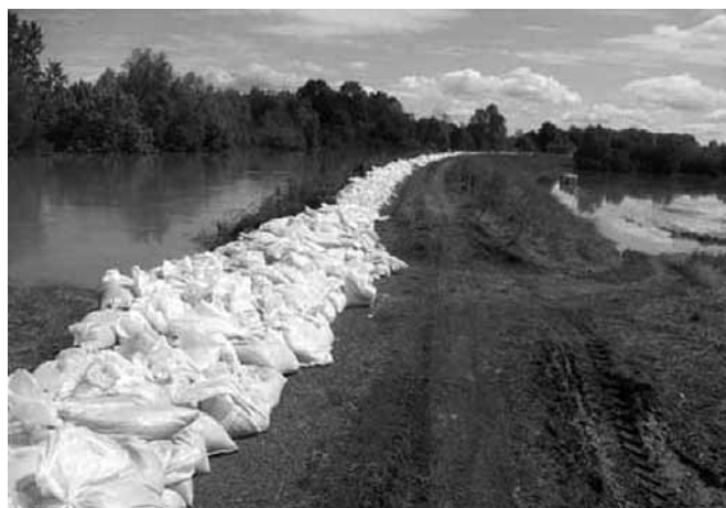
Oštećenja na krunu savskog nasipa
