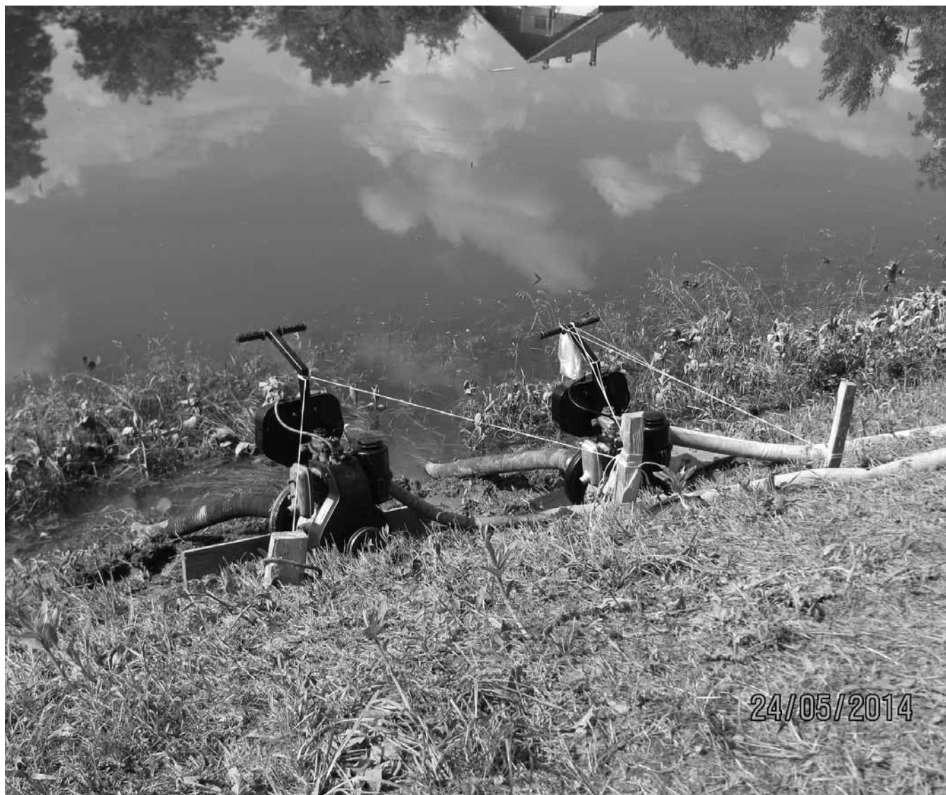
Foto 9: Evakuacija vode je vršena i dodatnim pumpama
