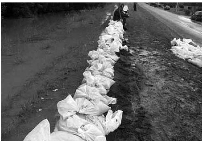
Oštećenja na krunu savskog nasipa
