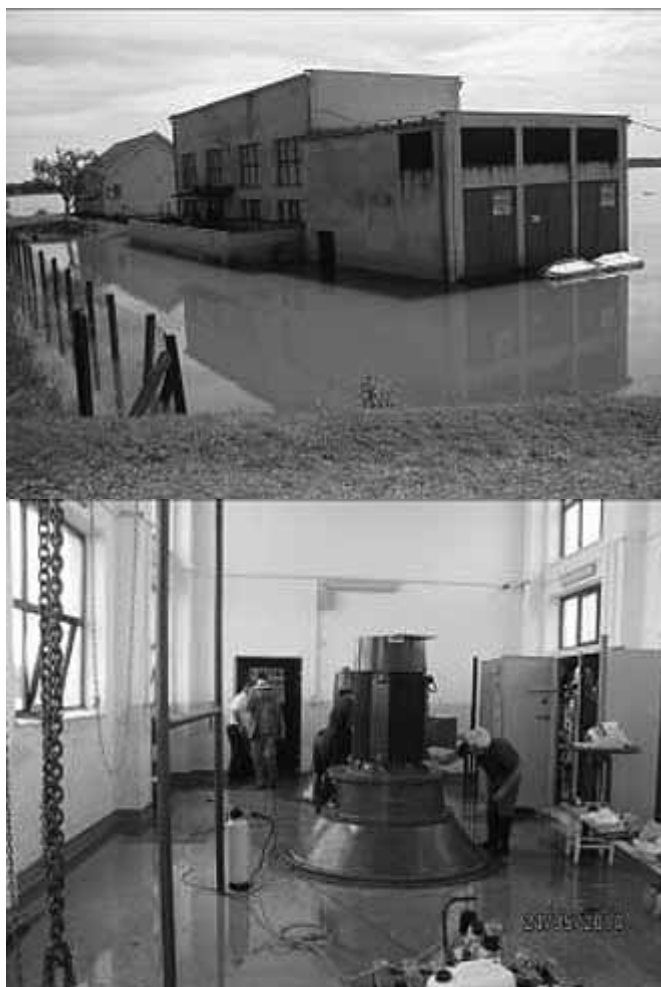
Foto 4: Poplavljena CS Zorice i aktivnosti na njenoj hitnoj sanaciji
