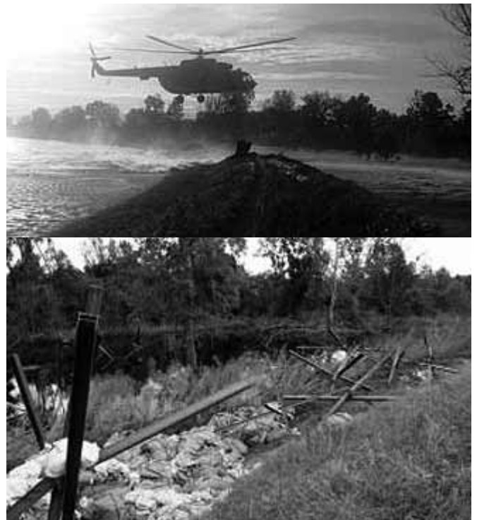
Foto 7: Hitne intervencije na zatvaranju proboja nasipa u Kopanicama
