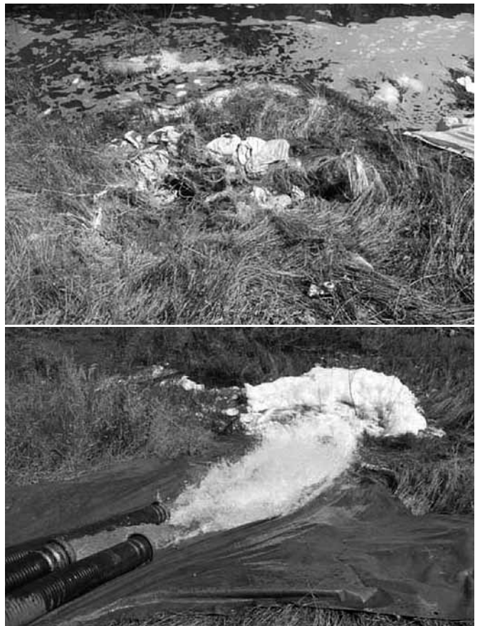
Oštećenja od aktivnosti prepumpavanja vode mobilnim pumpama
