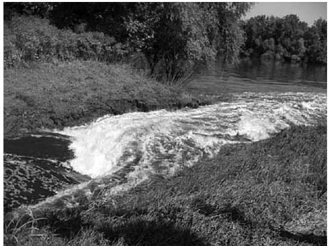
Ušće odvodnog kanala CS Tolisa
