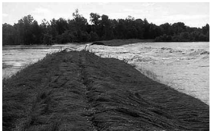
Proboji na savskom odbrambenom nasipu u Kopanicama
