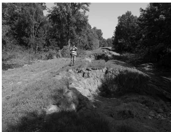
Proboji na savskom odbrambenom nasipu u Prudu
