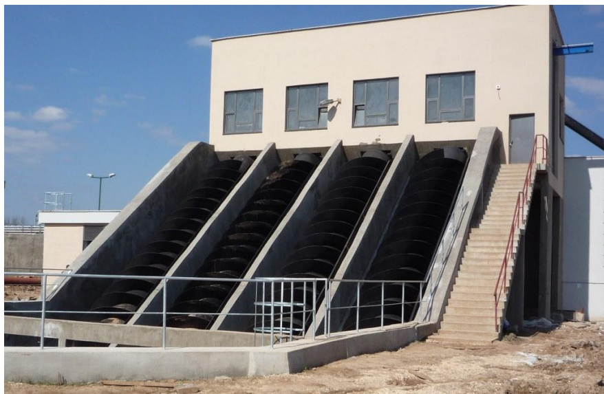
Slika 1. Ulazna pumpna stanica
