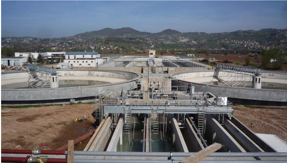
Slika 2. Aerisani pjeskolov i primarni taložnici
