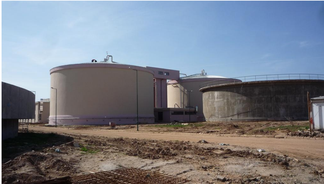
Slika 3. Digestori mulja
